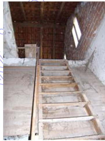
Scala d'accesso al piano primo (sottotetto)
