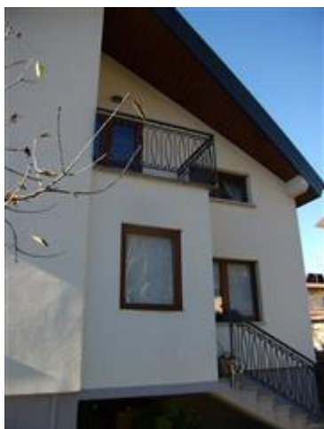
Poggiolo fronte strada
