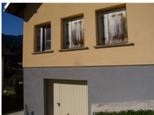
Fronte est del fabbricato
