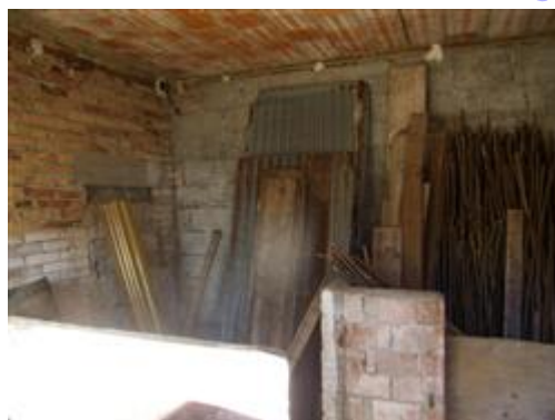
Ripostiglio piano seminterrato
