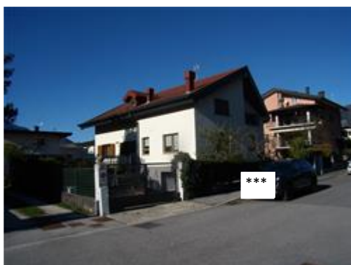
Angolo sud est del fabbricato dalla Via Gorizia
