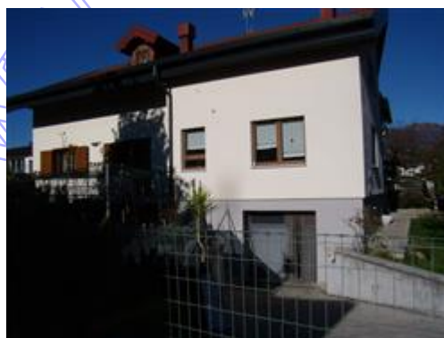
Fronte sud e rampa d'accesso all'autorimessa
