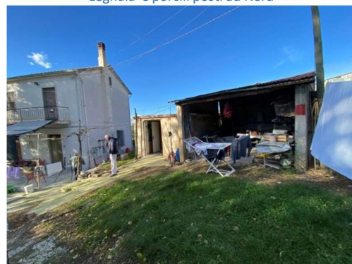
Loclai bagno\lavanderia e tettoia posti ad Ovest
