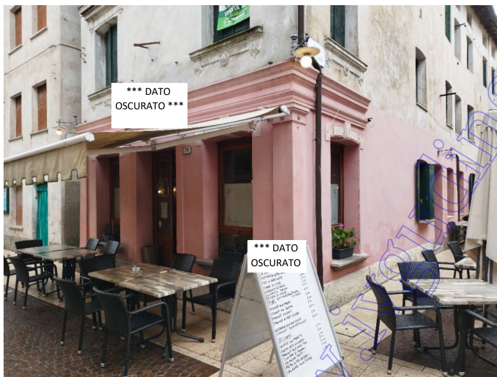
Particolare prospetto su strada pubblica
