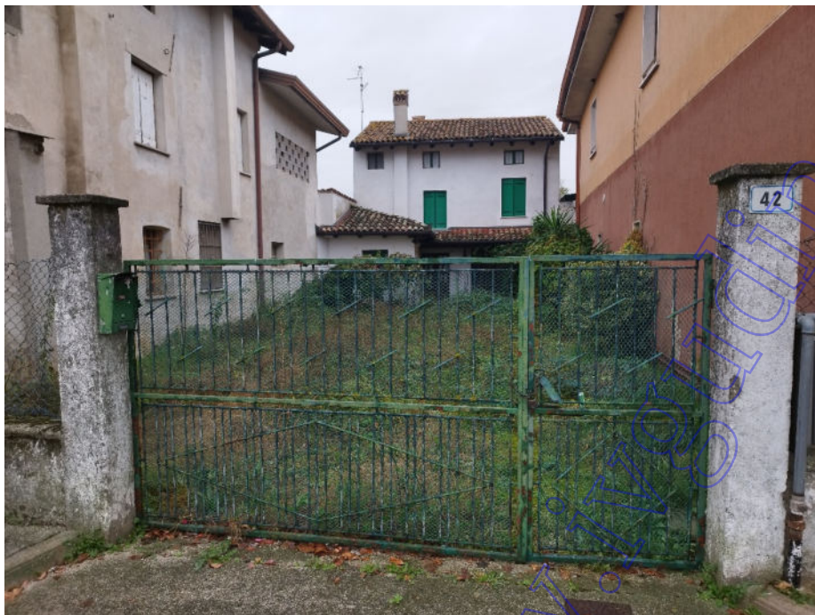
Particolare prospetto su strada pubblica
