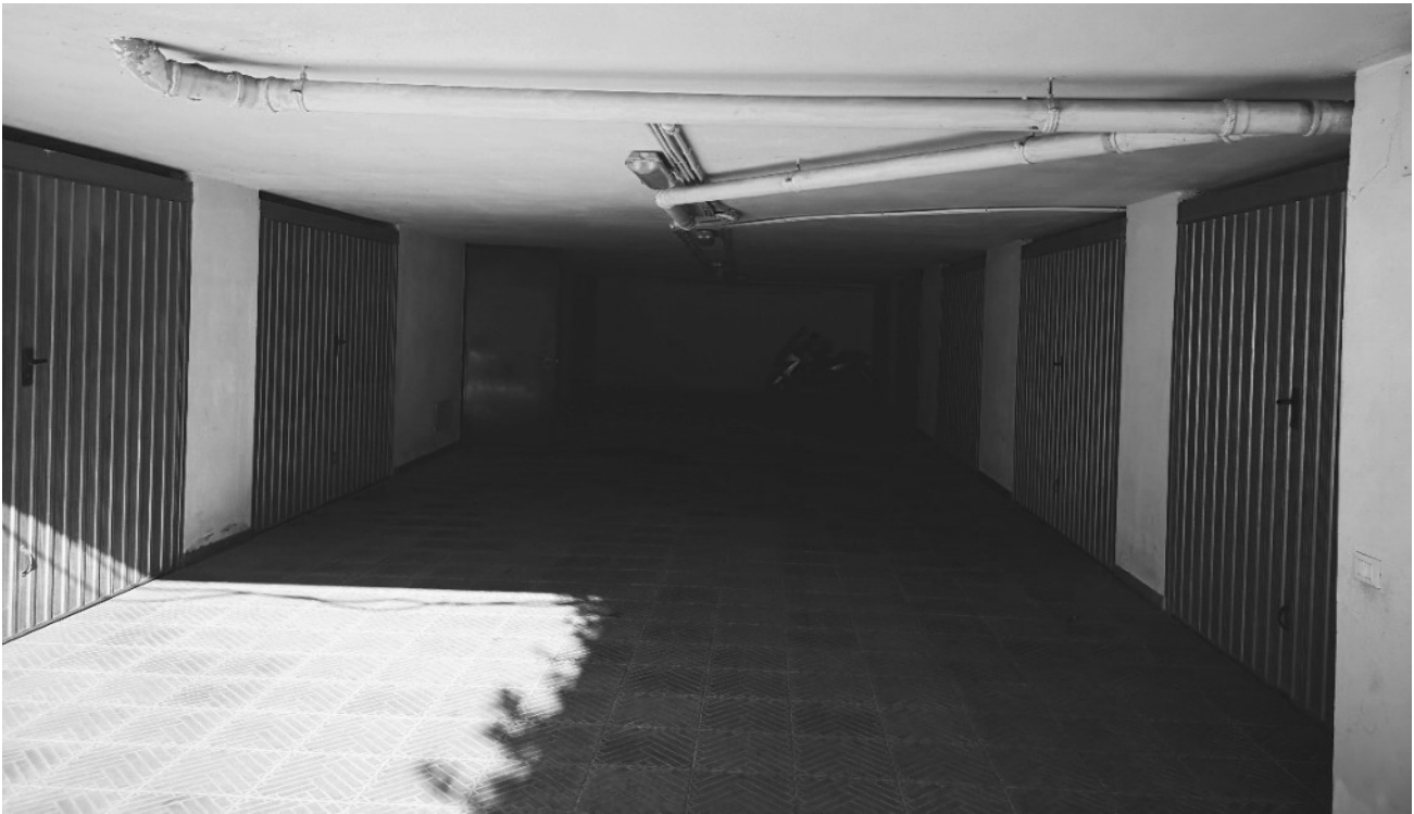
29 - Piano interrato - Area di manovra
