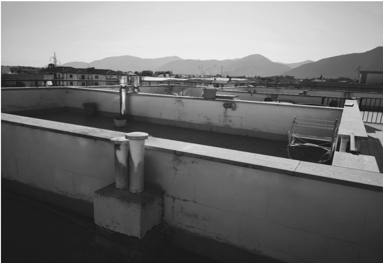
27 - Porzione di lastrico solare
