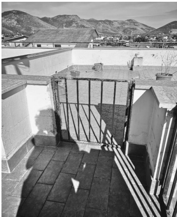
28 - Porzione di lastrico solare
