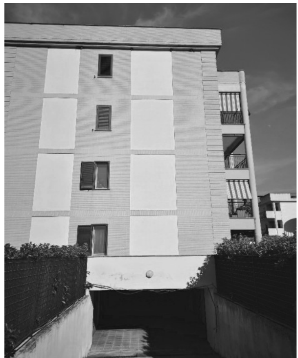
31 - Rampa di accesso piano interrato
