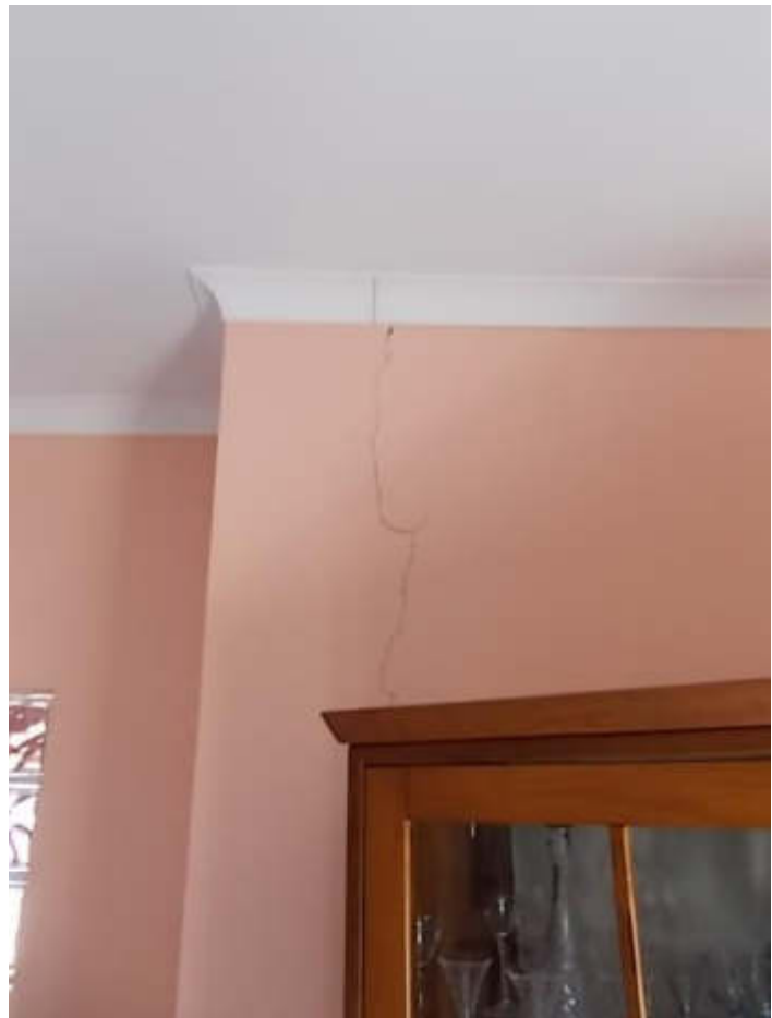
viste delle lesioni da distacco visibili nell'alloggio pignorato
