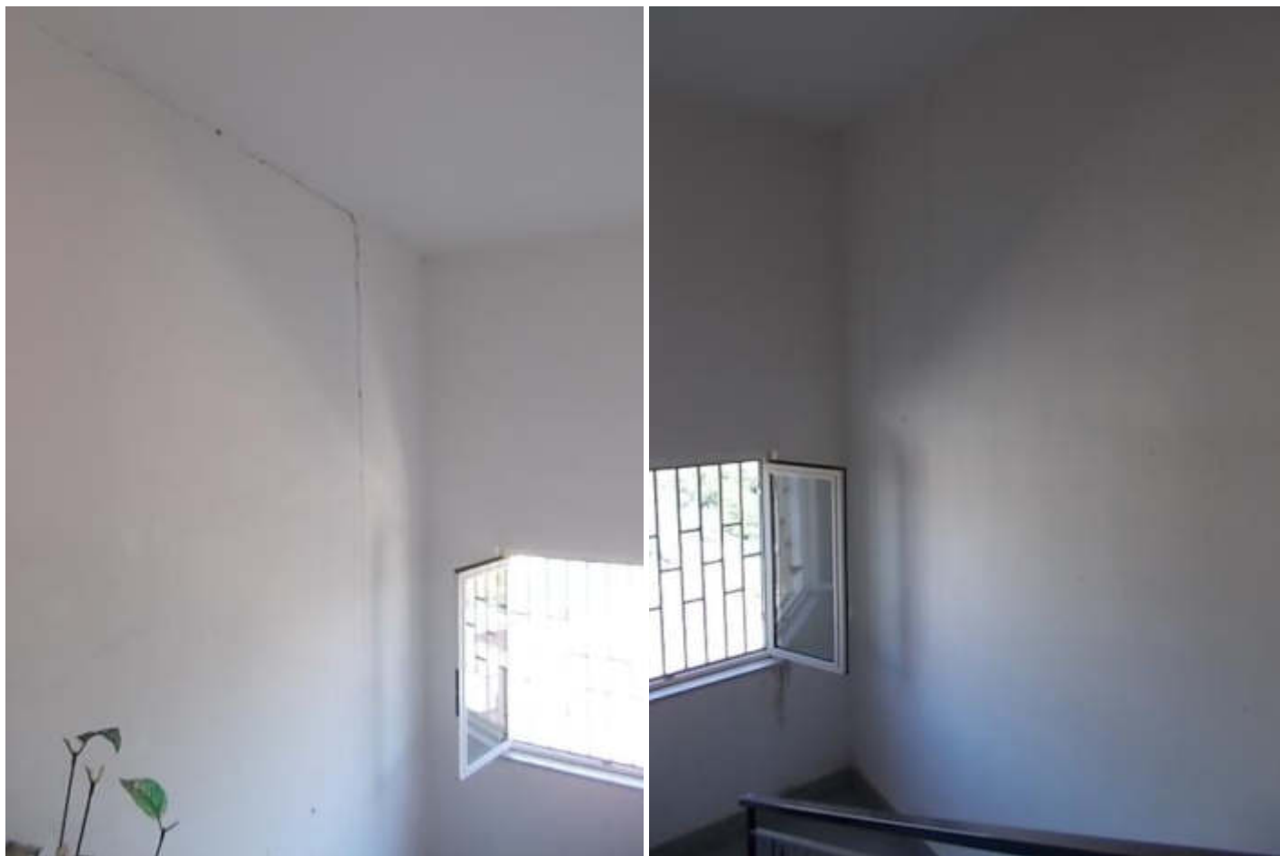
viste delle lesioni da distacco visibili nella scala del fabbricato
