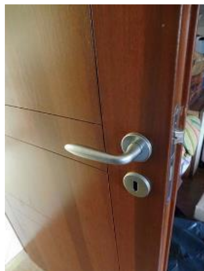
_dettaglio degli infissi
