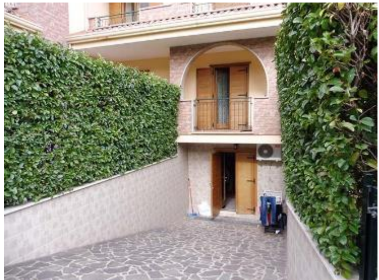
_accesso al seminterrato dalla rampa esterna
