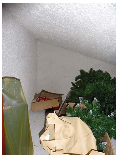
_disimpegno sottotetto e deposito
