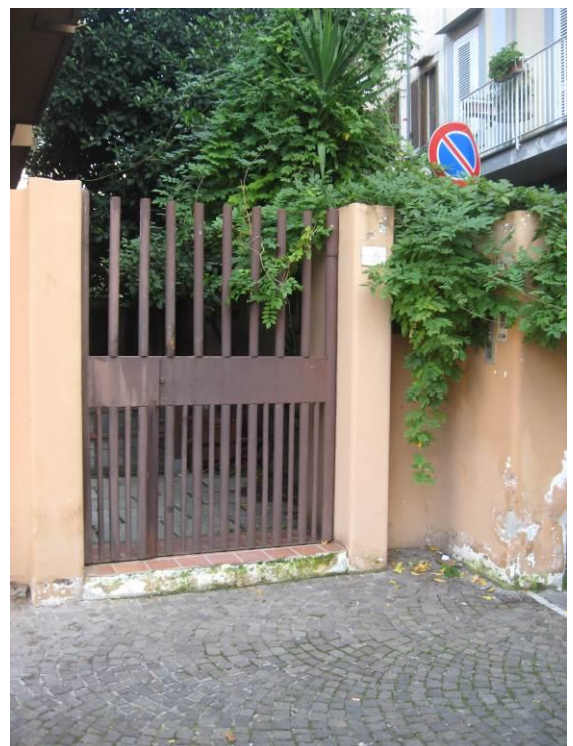
Figura 6 accesso al fabbricato da piazza Geremia Trinchese in Nola
