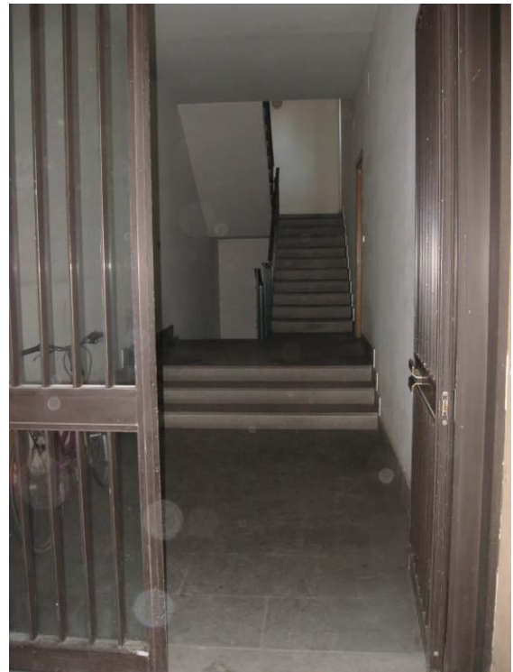
Figura 8 accesso al vano scala del fabbricato
