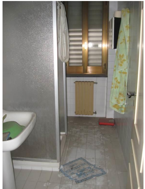
Figure 18 bagno 2 dell'appartamento pignorato
