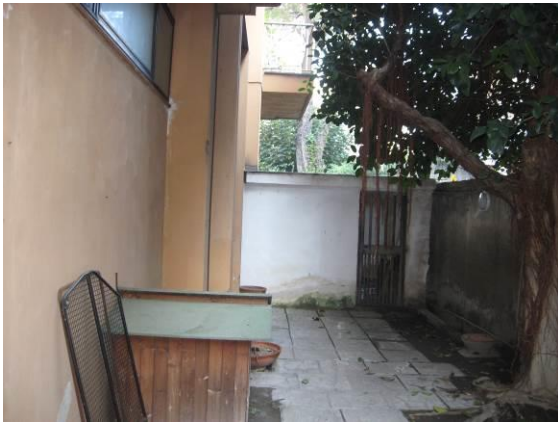
Figura 7 cortile interno di accesso al vano scala del fabbricato
