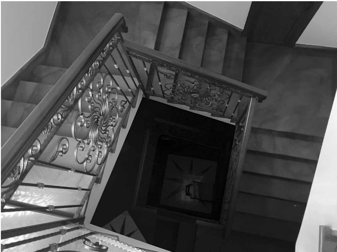
Blocco Scala - sub. 3 -
