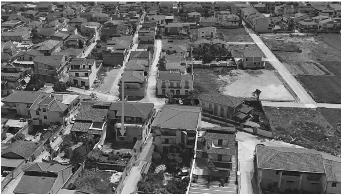
Viste dall'alto del fabbricato
