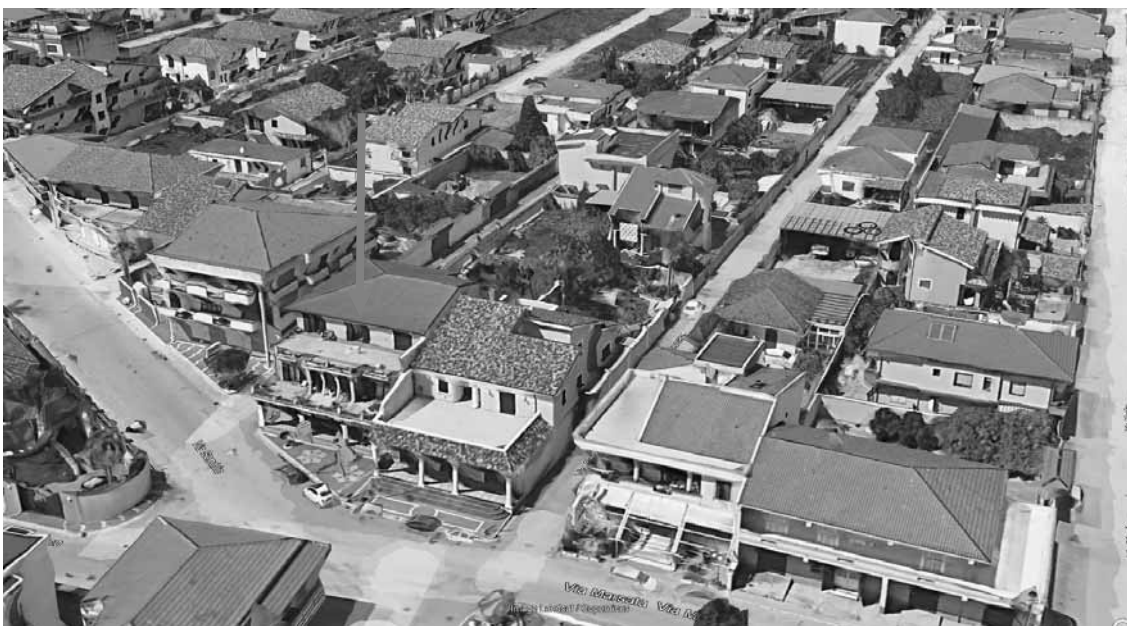
Viste dall'alto del fabbricato
