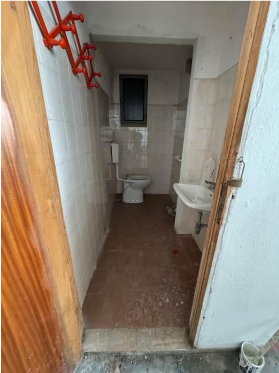
Figura 6: Vista interna, bagno
