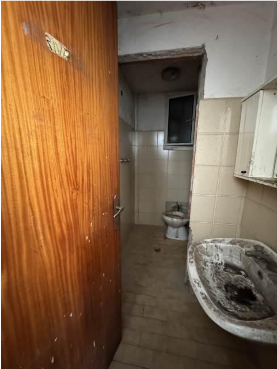
Figura 7: Vista interna, bagno
