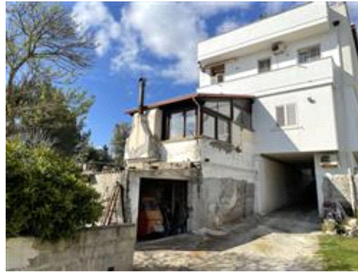
Vista del terrazzo a livello con copertura e infissi da demolire e vista della centrale idrica al piano sottostante censita come BCNC sub. 5
