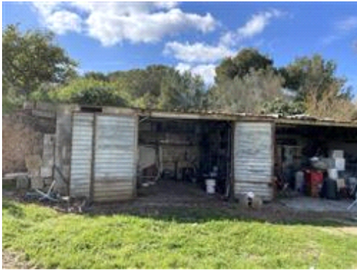
Vano accatastato come tettoia (F. 206, p.360, sub. 4)
