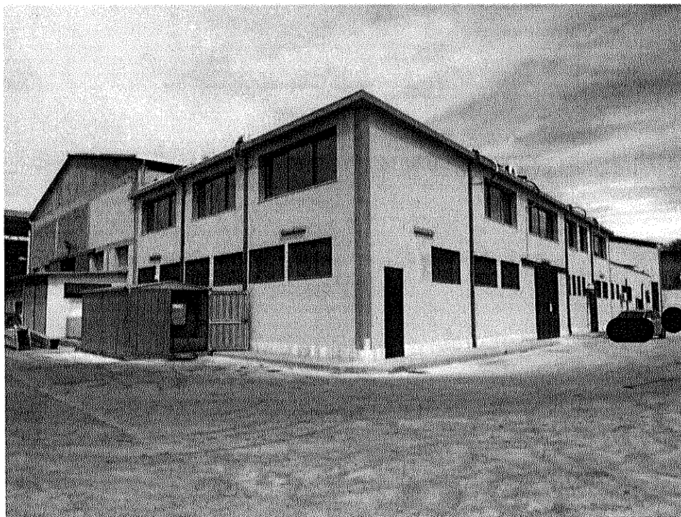
Foto 1. Vista esterna del fabbricato industriale.
