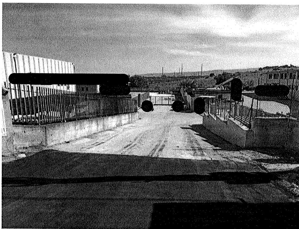
Foto 2. Vista della stradella. Sulla destra l'accesso al fondo oggetto di pignoramento.
