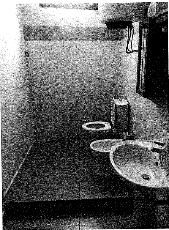
Foto 10. Vista del servizio igienico (WC 1).
