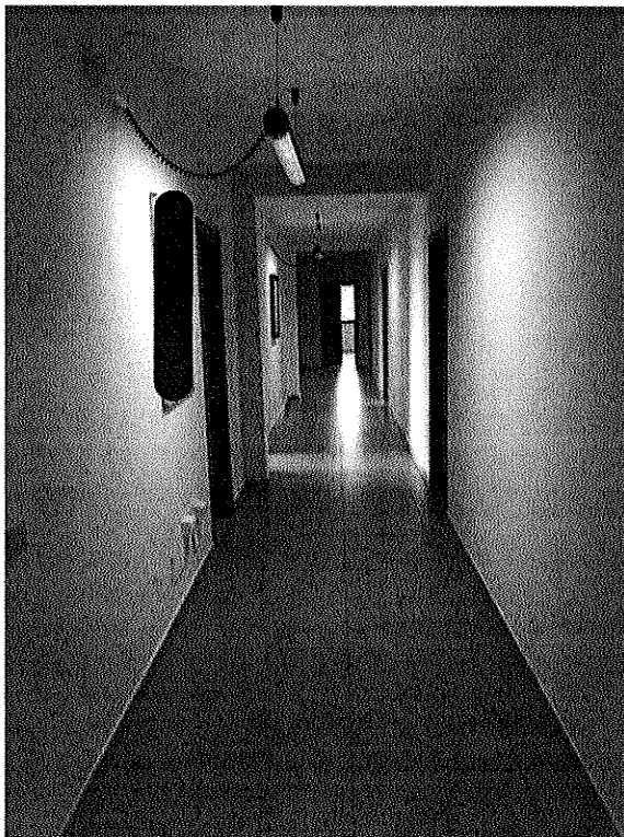
Foto 19. Vista del corridoio.
