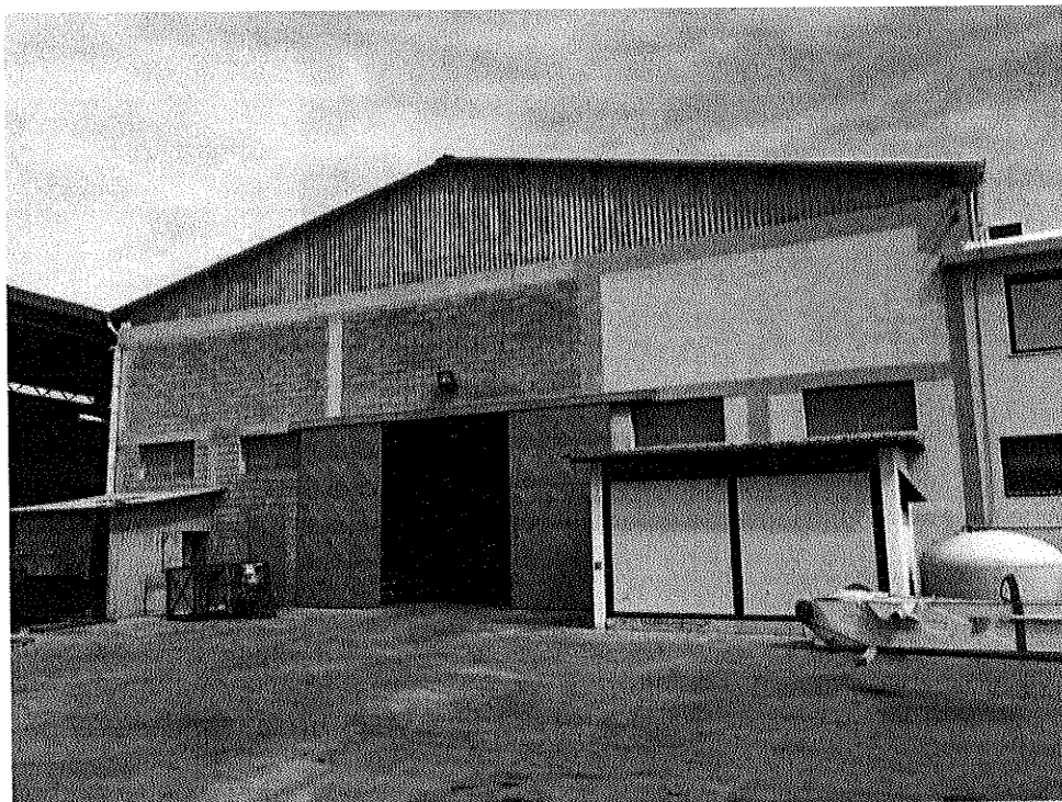
Foto 3. Vista esterna del fabbricato industriale, blocco area lavoro-deposito.
