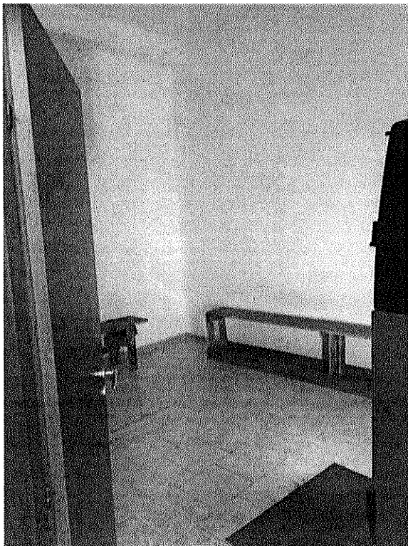
Foto 13. Vista degli spogliatoi.
