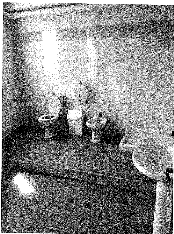
Foto 25. Vista del servizio igienico (WC 2).
