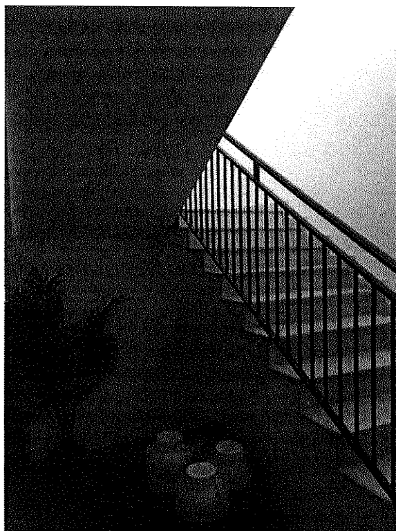
Foto 16. Vista del vano scala.
