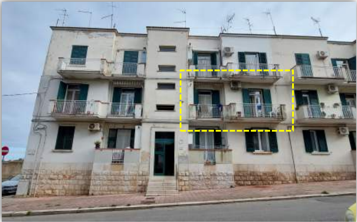
foto n.1 - prospetto anteriore, con ingresso da Viale Giuseppe di Vittorio 1
