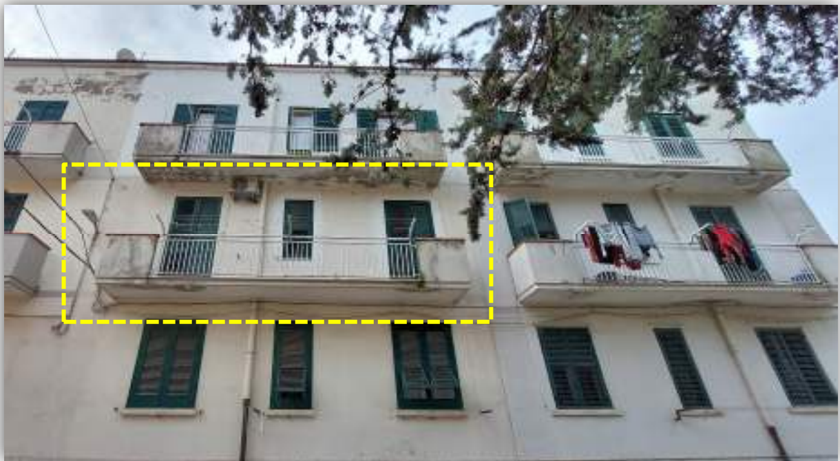
foto n.2 - prospetto retrano su Traversa Via Cavoni
