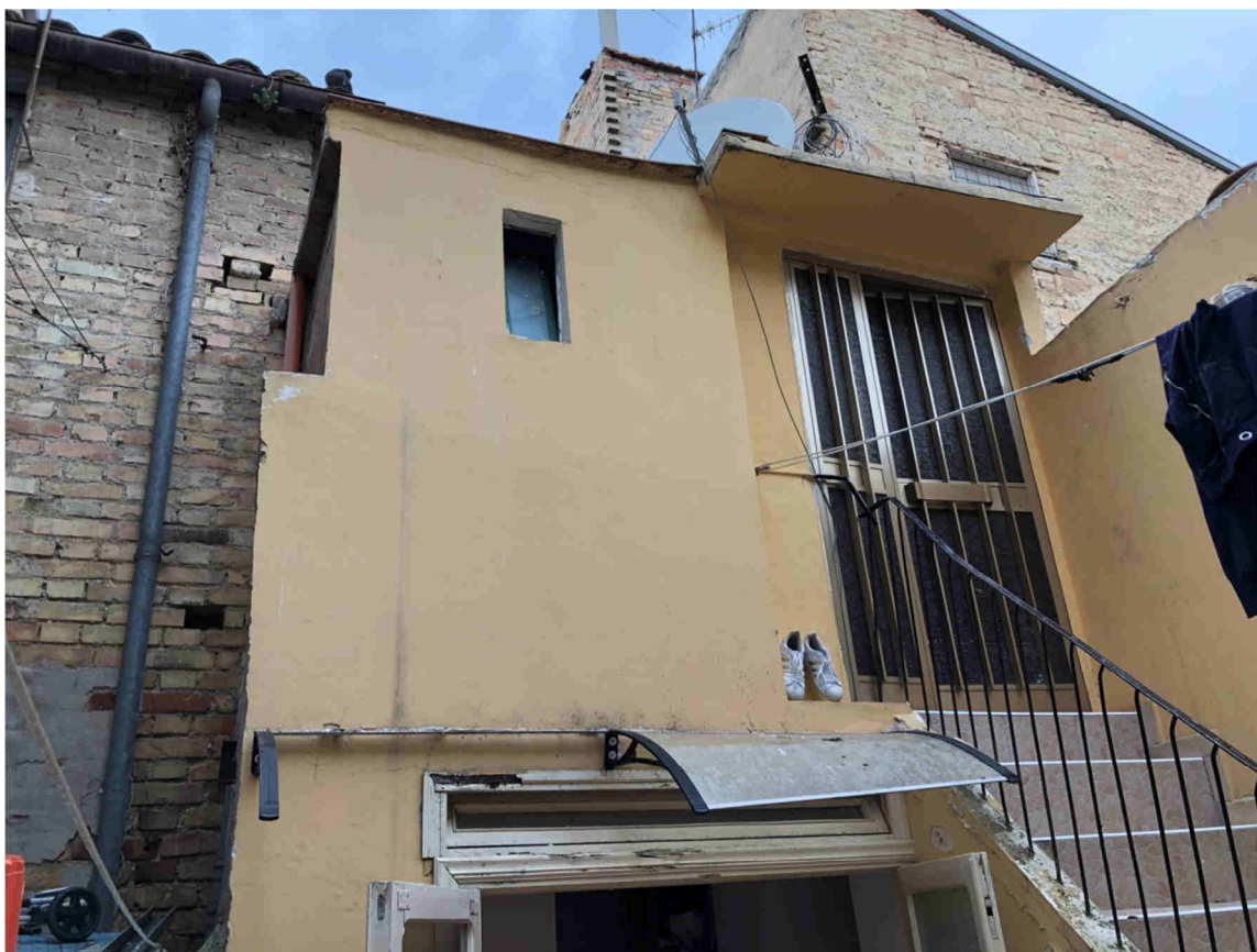
Foto n.9 – Ingresso piano primo
