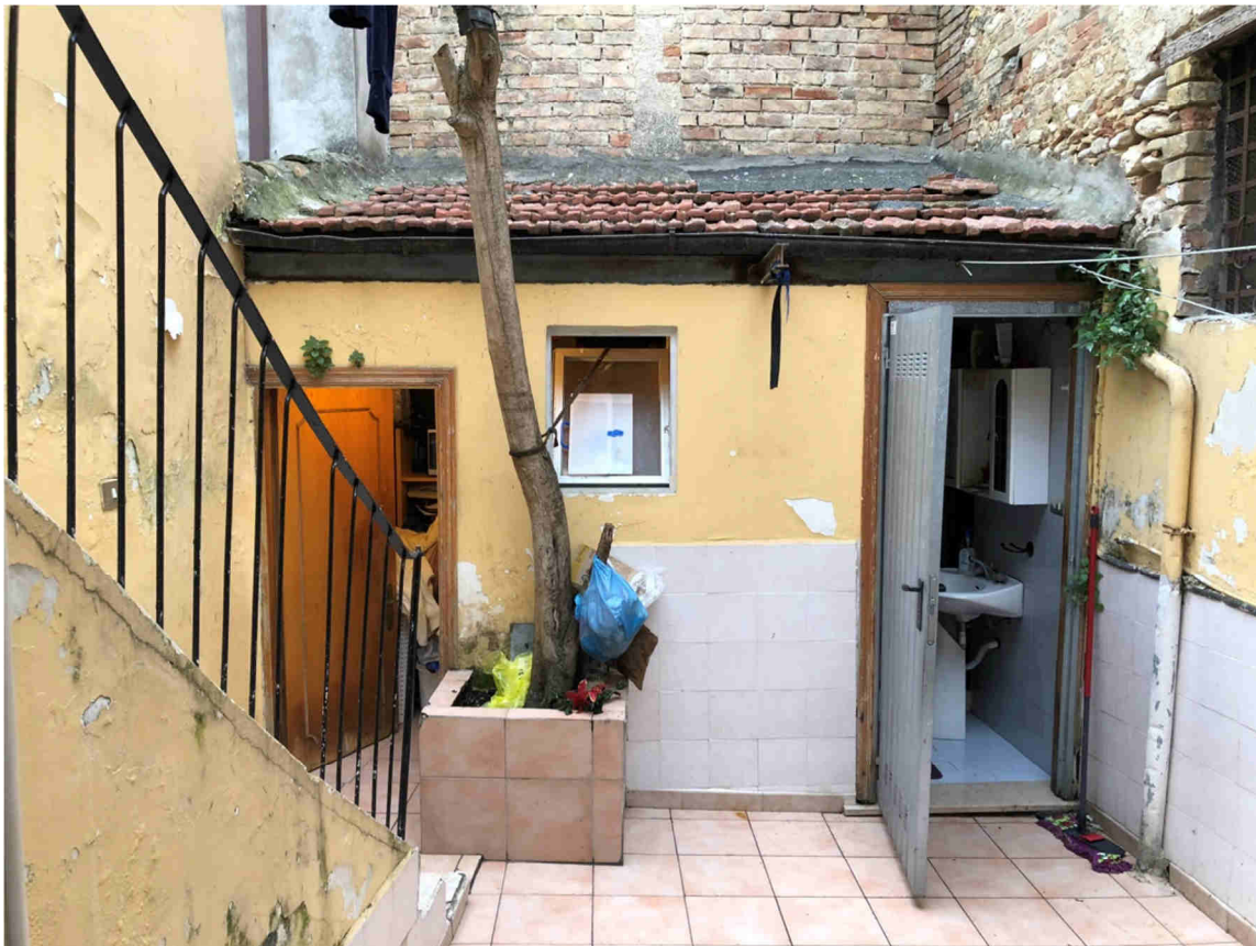
Foto n.7 – Piano terra (cortile interno con w.c. e ripostiglio)
