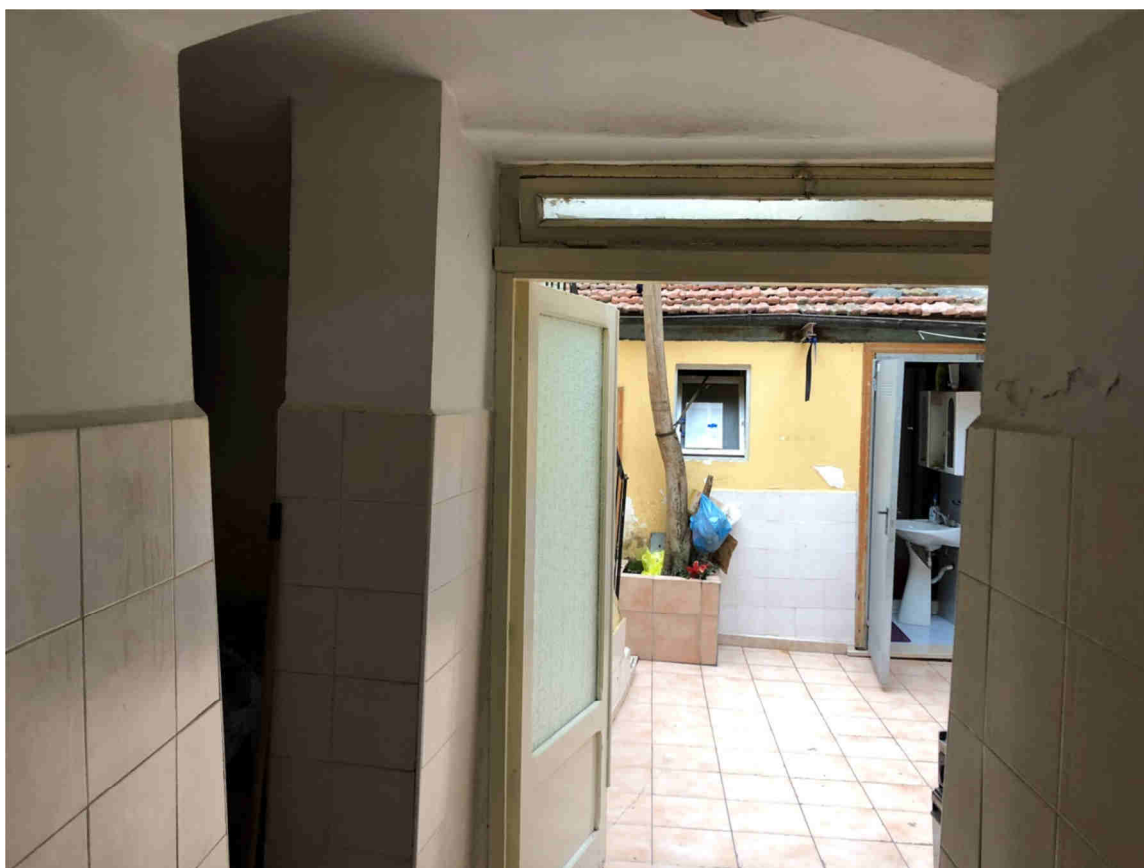
Foto n.6 – Piano terra (Ripostiglio – uscita su cortile interno)
