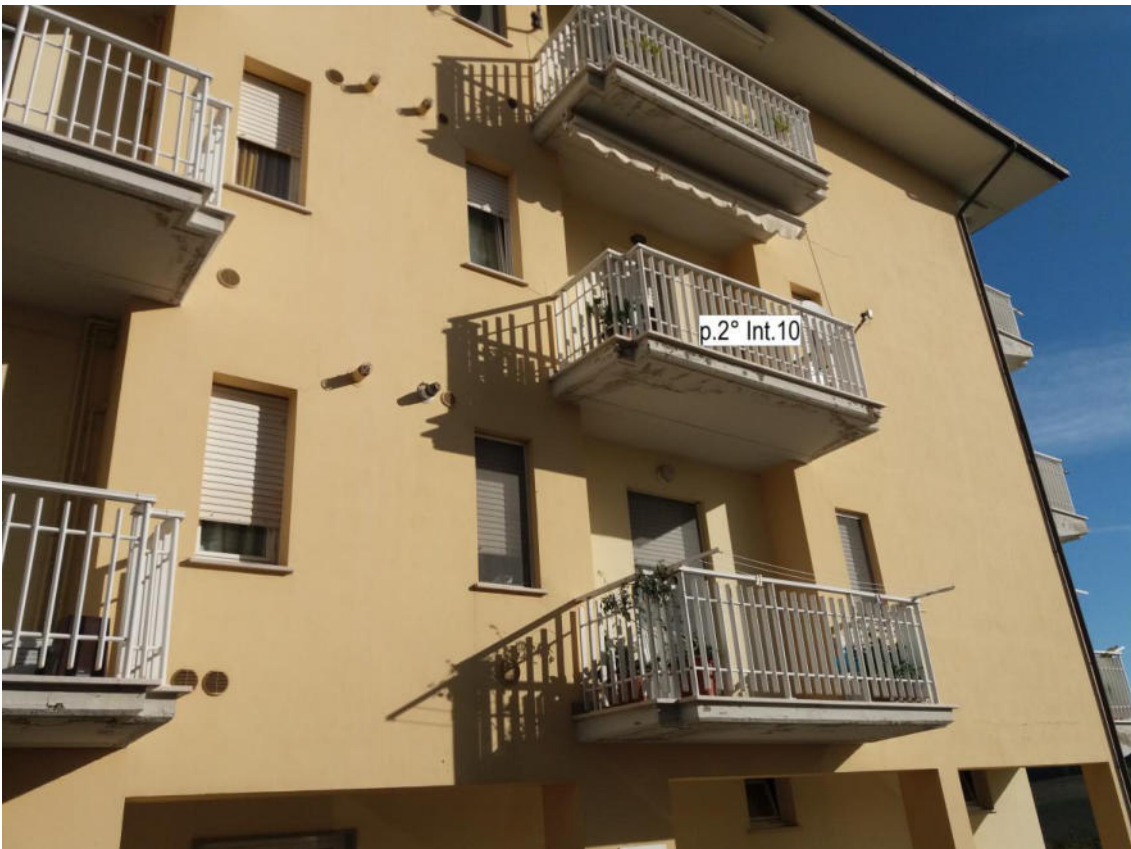
FOTO B_facciata immobile Sud
