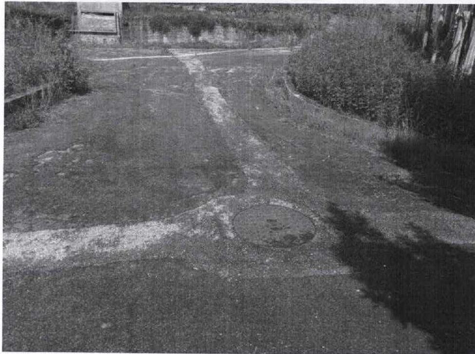
Foto n°10: tracciato della fognatura sulla proprietà
