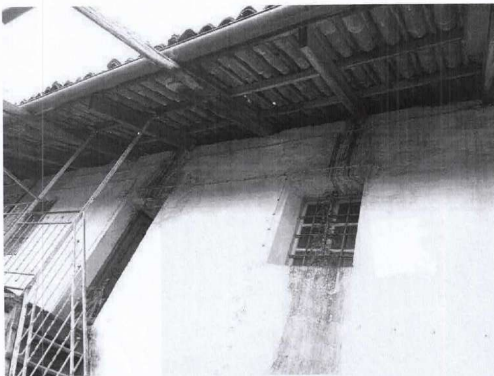
Foto n°23: colature d'acqua proveniente dal tetto e muffe sulla facciata
