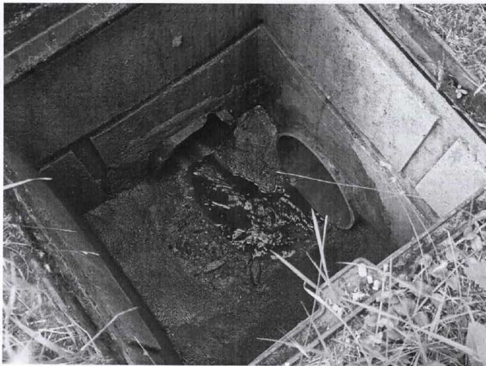
Foto n°9: primo pozzetto fognario sulla proprietà
