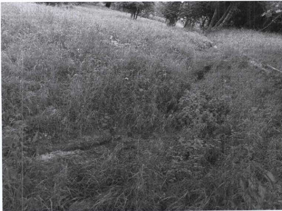
Foto n°18: reflui fognari che percorrono il versante prativo
