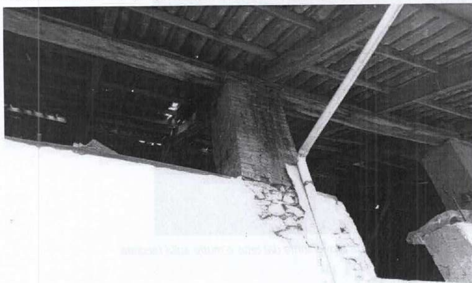
Foto n°23: colature d'acqua proveniente dal tetto e muffe sulla facciata
