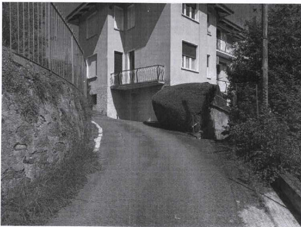
Foto 3: edificio particella n°370, diritto di passaggio sulla strada di accesso pr. l
