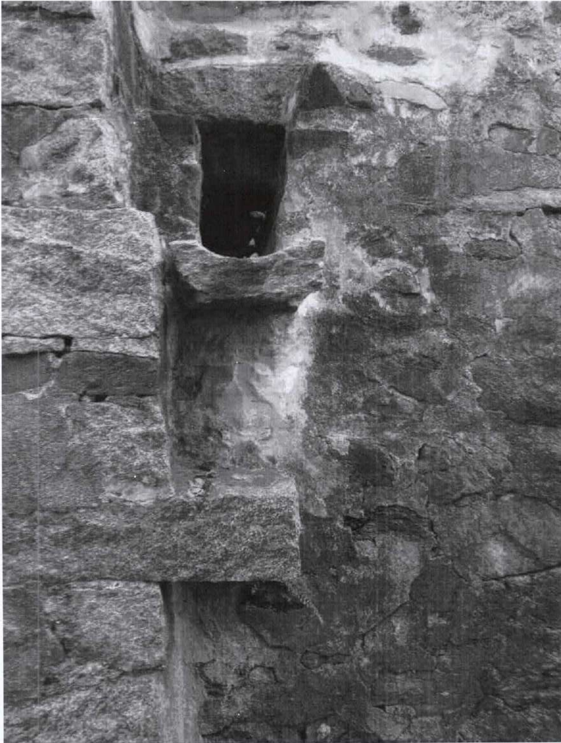
Foto n°11: particolare doccione di scarico sul vicolo
