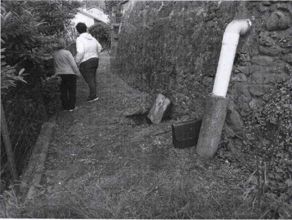
Foto n°5: vicolo con pozzetto fognario
