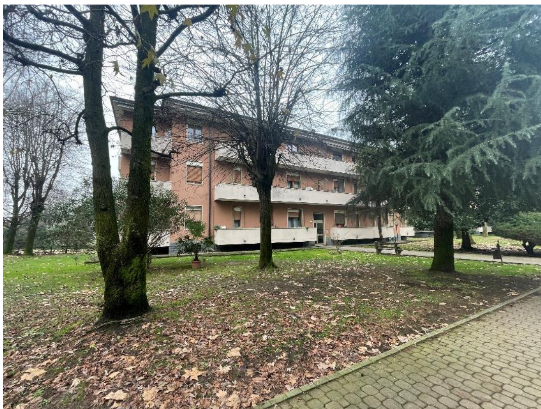
Fabbricato in Via Gamblina 42 – Edificio 1
