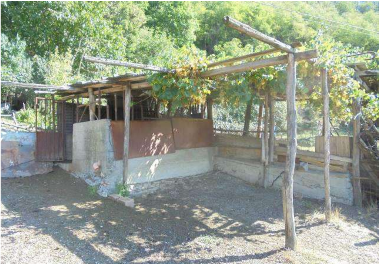
Foto 49 e 50 - vista del fabbricato rurale abusivo presente sul mappale 752
