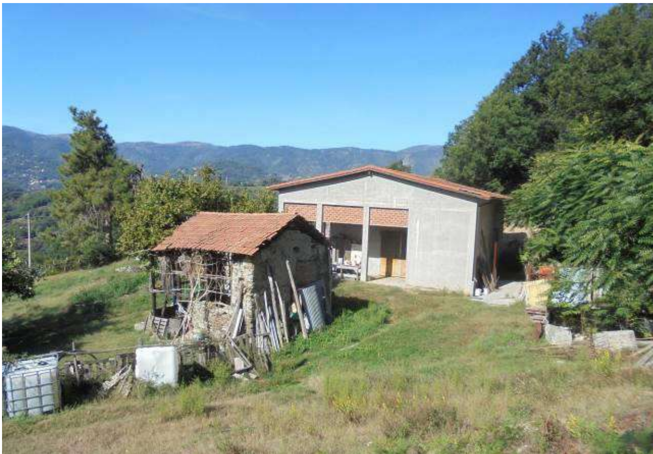
Foto 7 – vista del rudere (mapp. 505) e della stalla (mapp. 618) guardato dall'interno del lotto di proprietà (mapp. 504)
