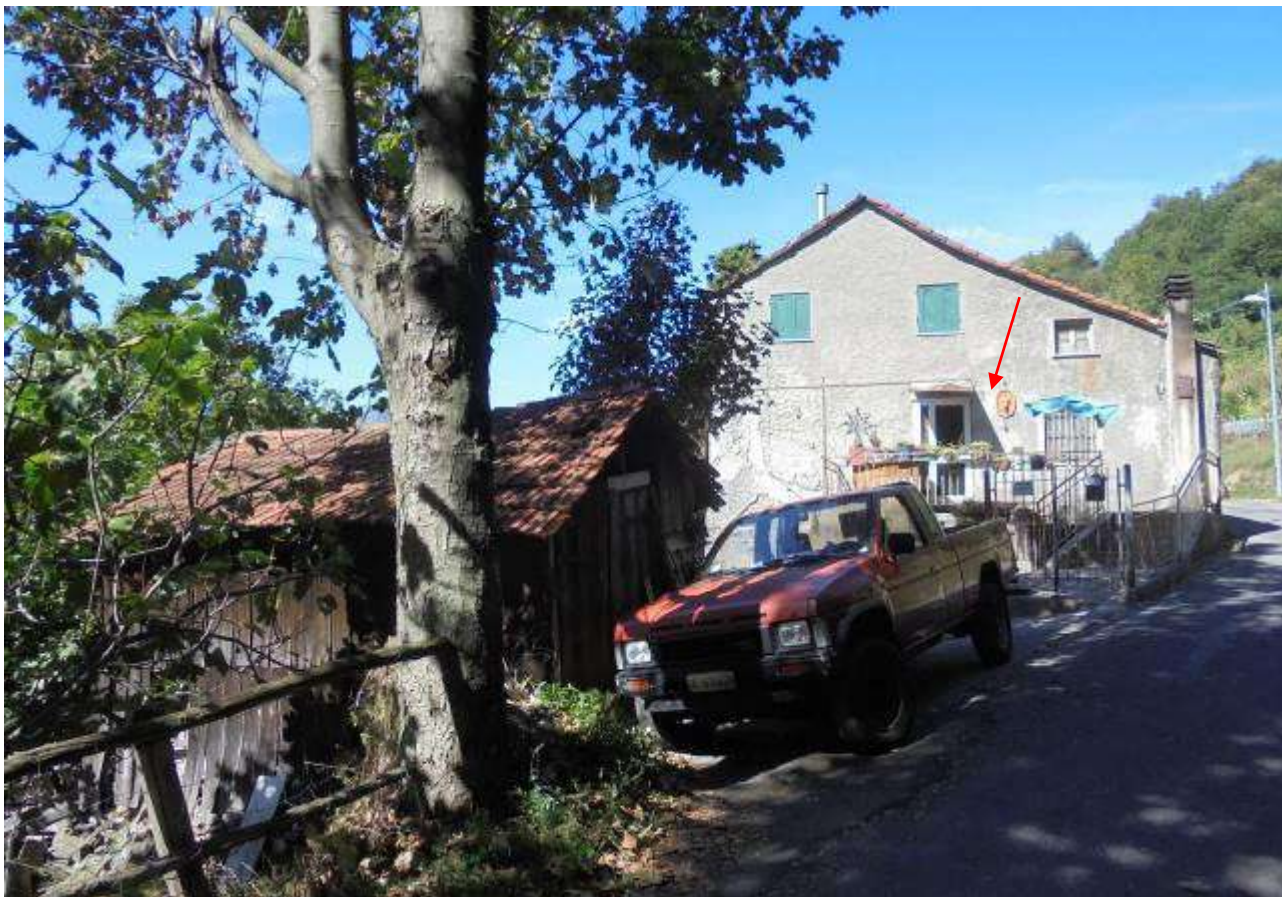
Foto 22 - Vista dell'immobile rurale arrivando da valle – in evidenza l'ingresso al civico 24 Sulla sinistra uno dei fabbricati non conformi presenti nell'area
