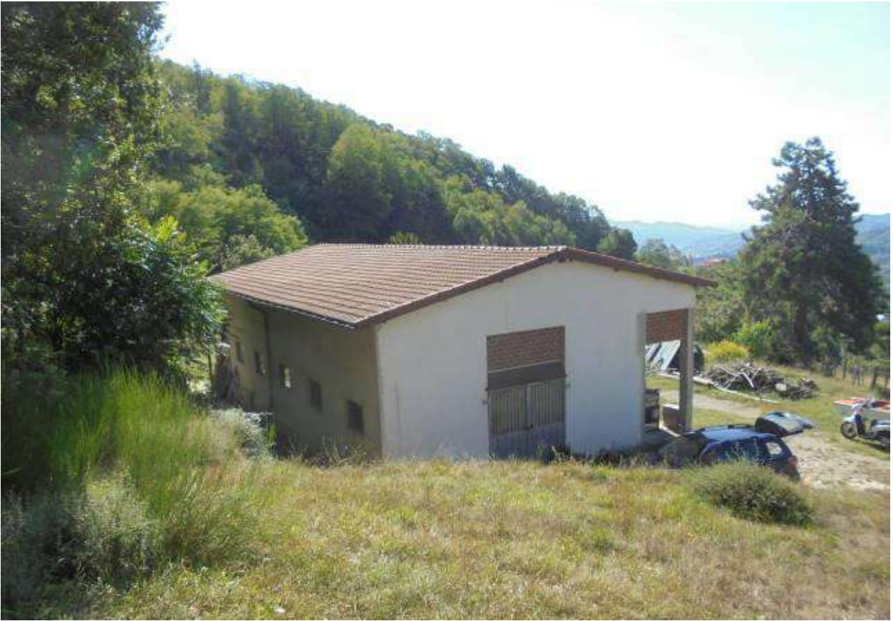
Foto 9 – vista della stalla da nord est
