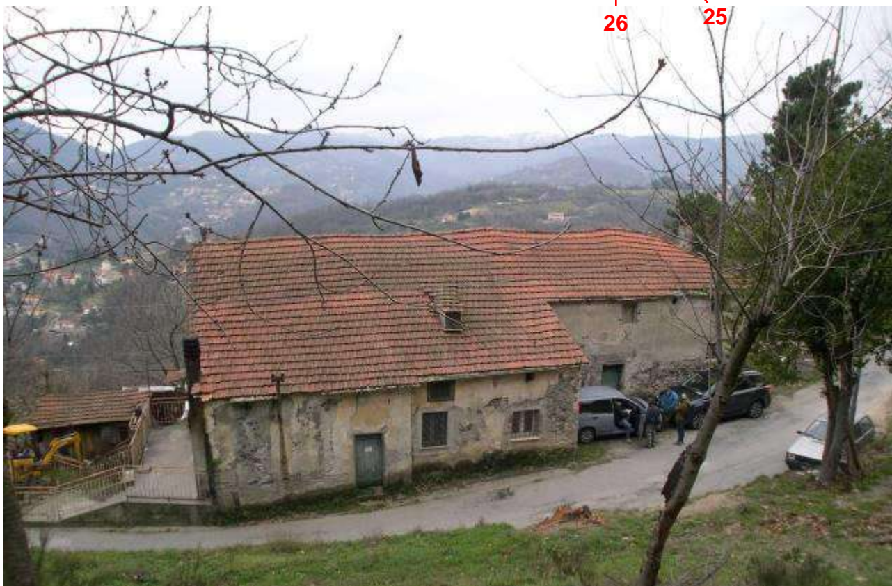
Foto 19 - Vista del fabbricato rurale (mapp. 560) nella sua interezza dall'alto
