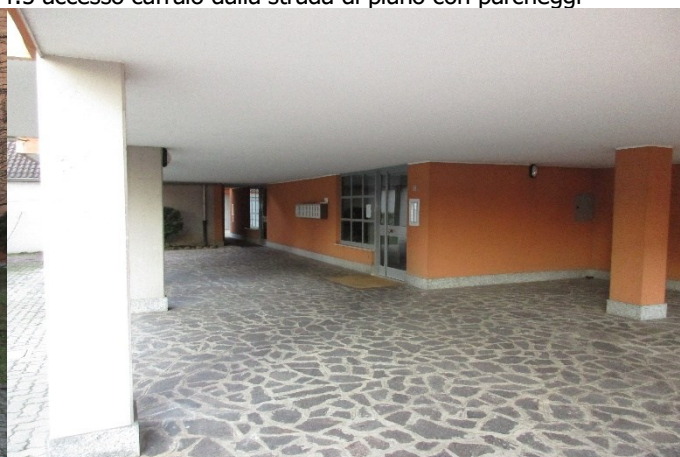
f.7 vista accesso alla scala C
