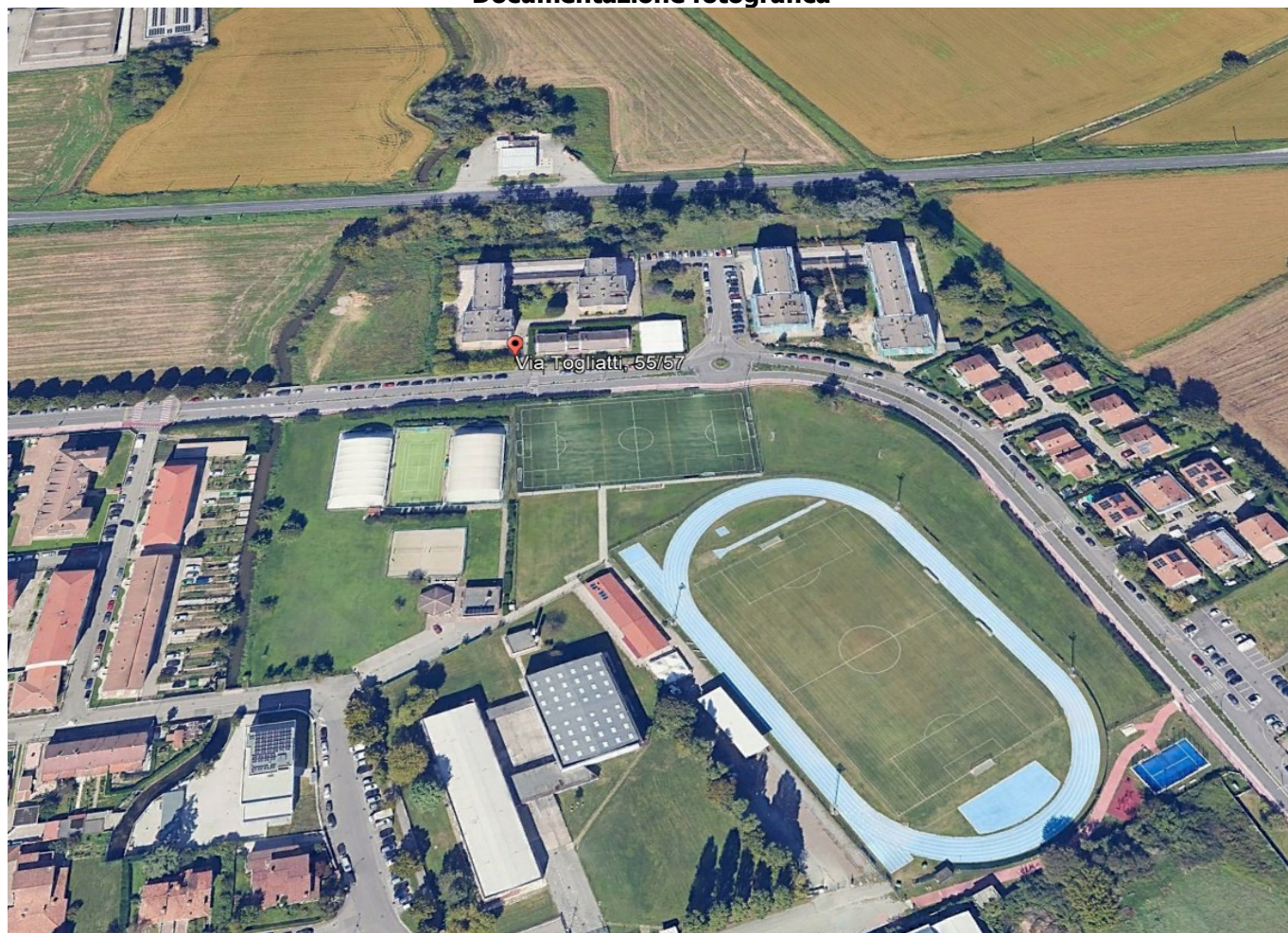
f.1 Vista aerea condominio e centro sportivo antistante
