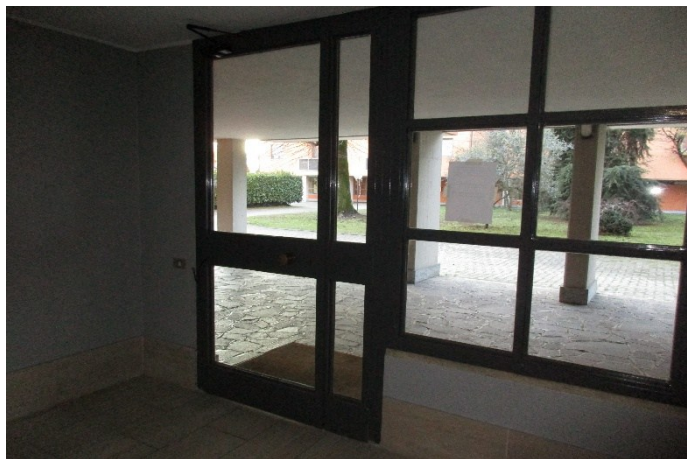
f.8 vista atrio ingresso scala C
