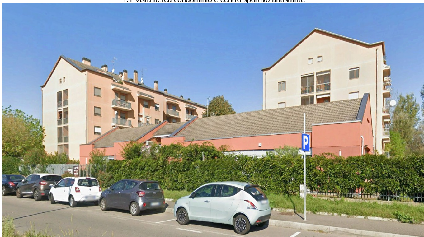
f.2 Vista condominio dalla via P. Togliatti e centro sportivo-ricreativo in corpo ad un piano
