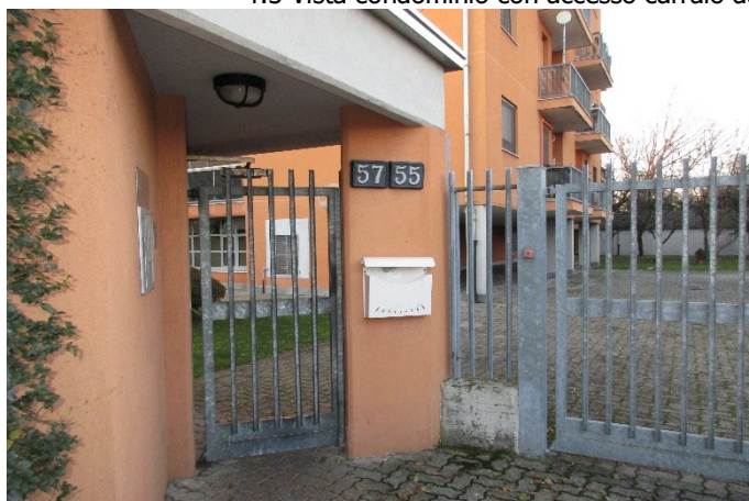
f.4 vista accesso dai civici 55/57 su via Togliatti
