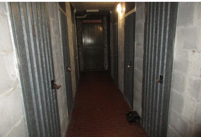
f.17 vista corridoio access alla cantina
