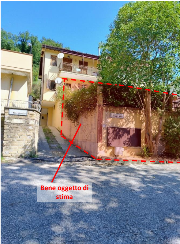
Foto 3 - Vista da via dei Pini
