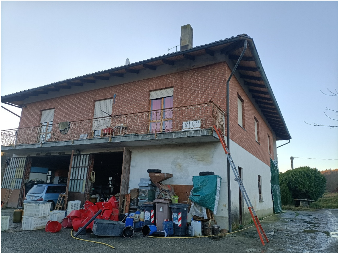
3-Fabbricato residenziale prospetto sud-est e nord-est
