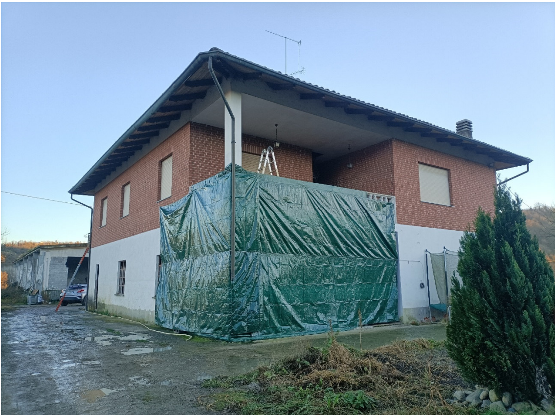
2-Fabbricato residenziale prospetto nord-ovest e nord-est
