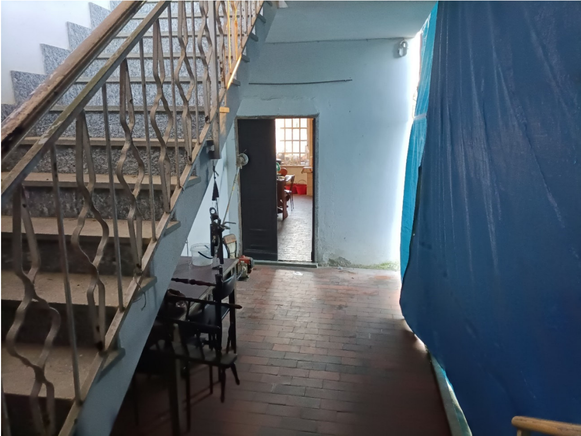
5-Fabbricato residenziale: vano scala esterno
