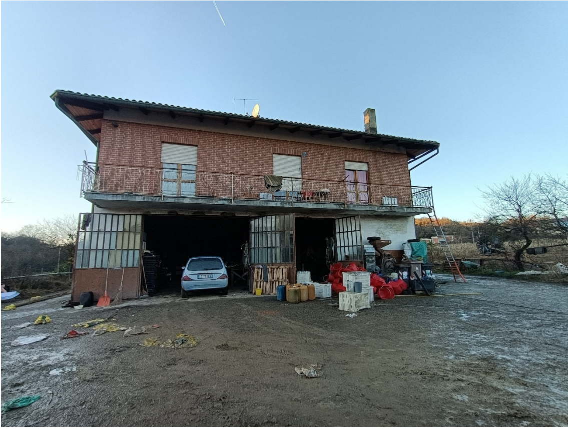
1-Fabbricato residenziale prospetto sud-est
