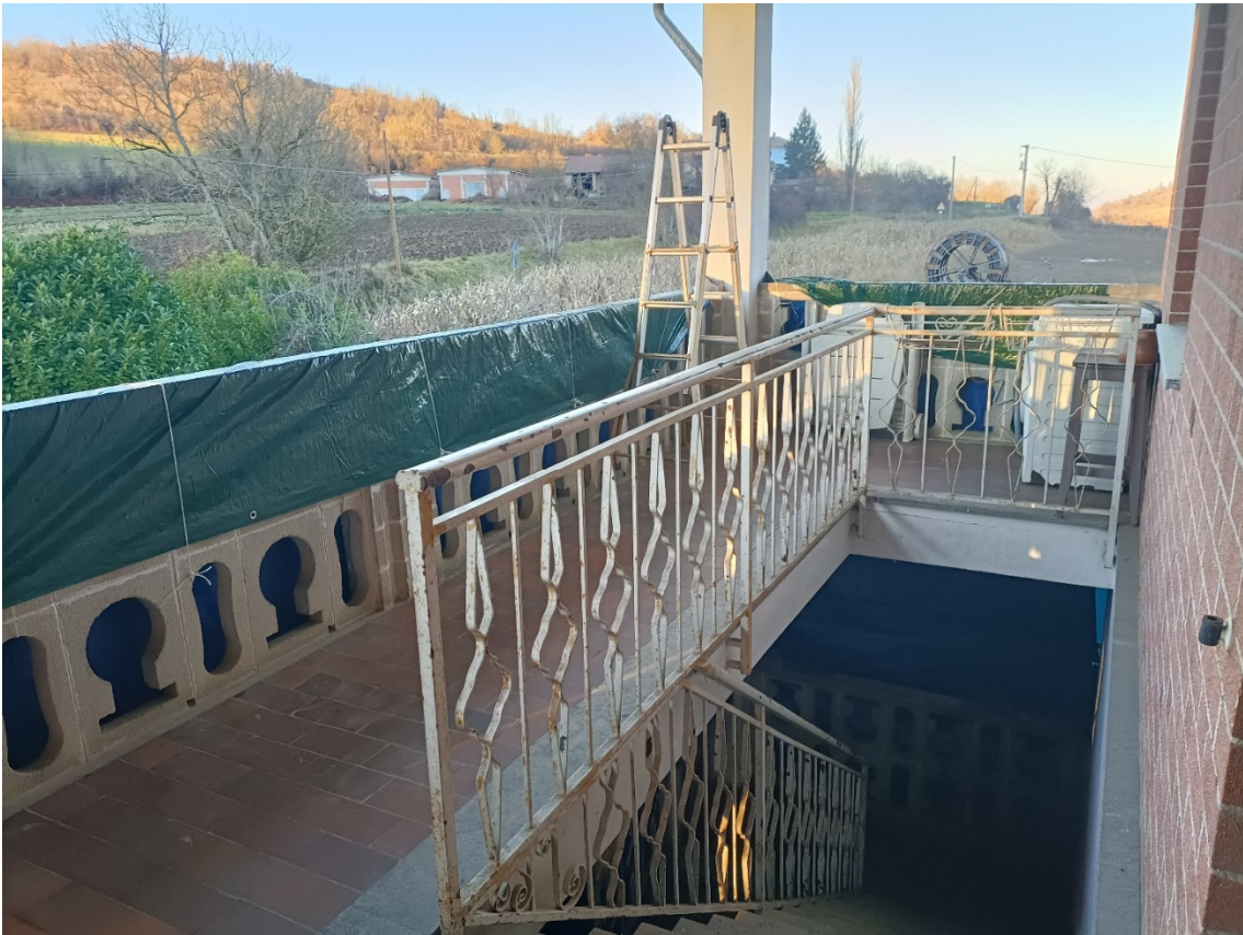
9-Abitazione: scala esterna di accesso
