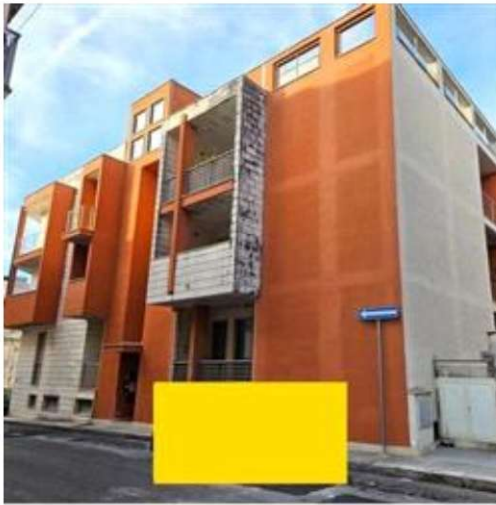
Prospetto fabbricato condominiale su via marconi
