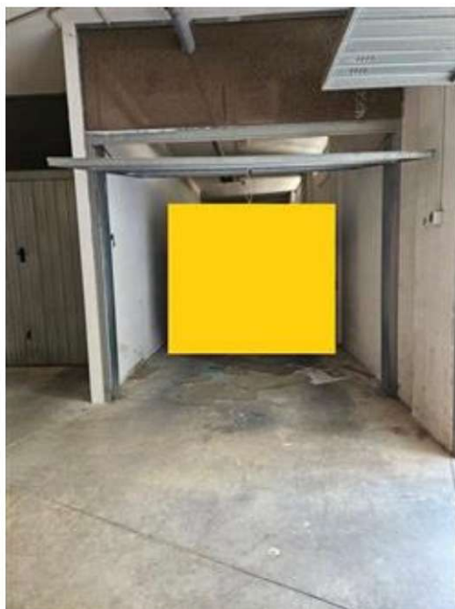
Box al piano interrato
