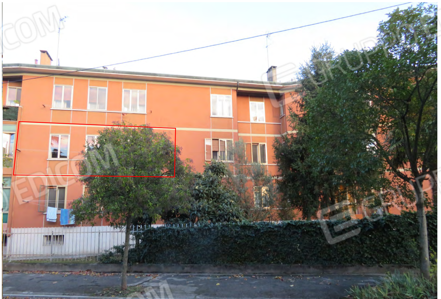
appartamento fronte ovest
