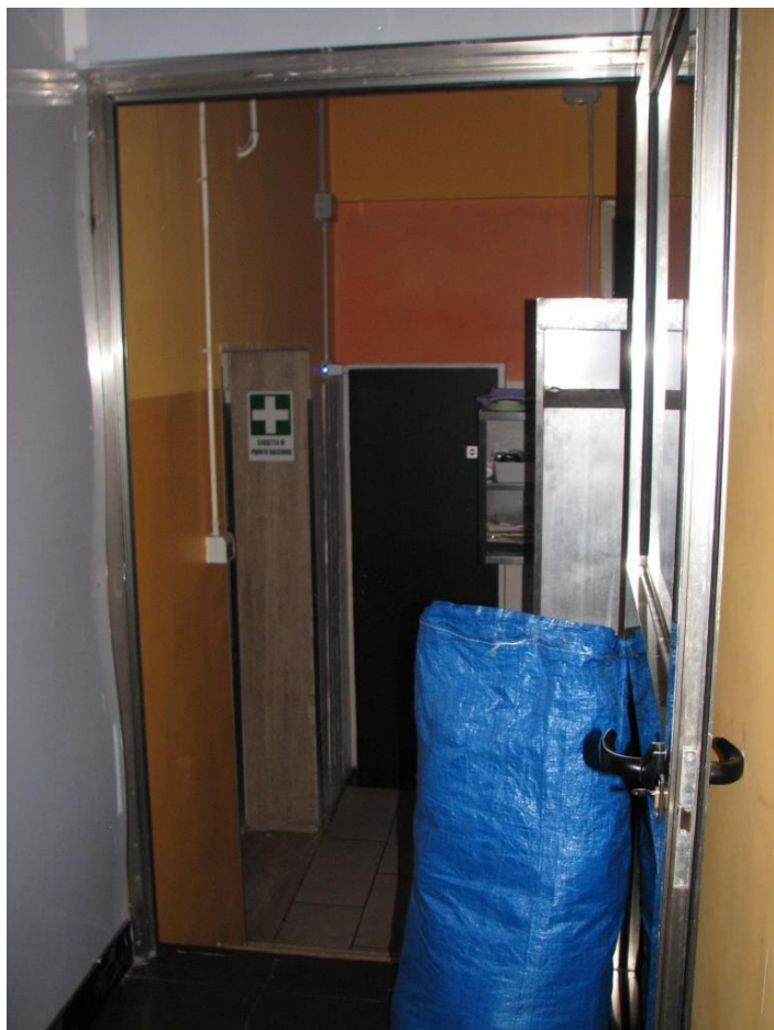
Foto 26 – Uscita di sicurezza (sul lato retrostante del locale)
