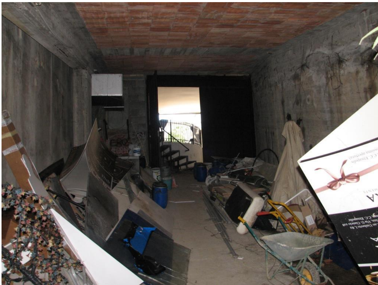
Foto 35 – Interno deposito, locale più piccolo
