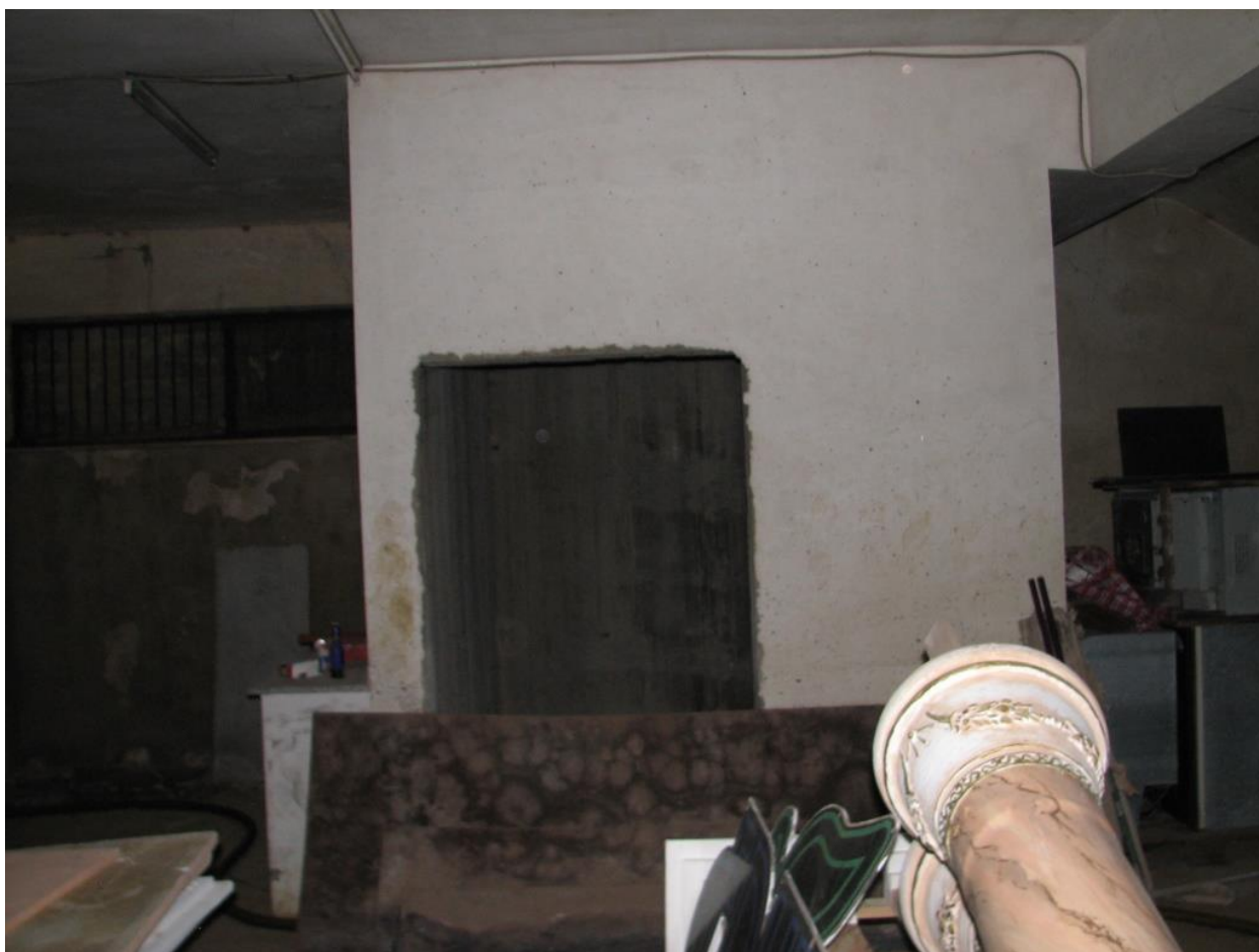
Foto 38 – Interno deposito, vano ascensore con uscita murata al piano superiore
