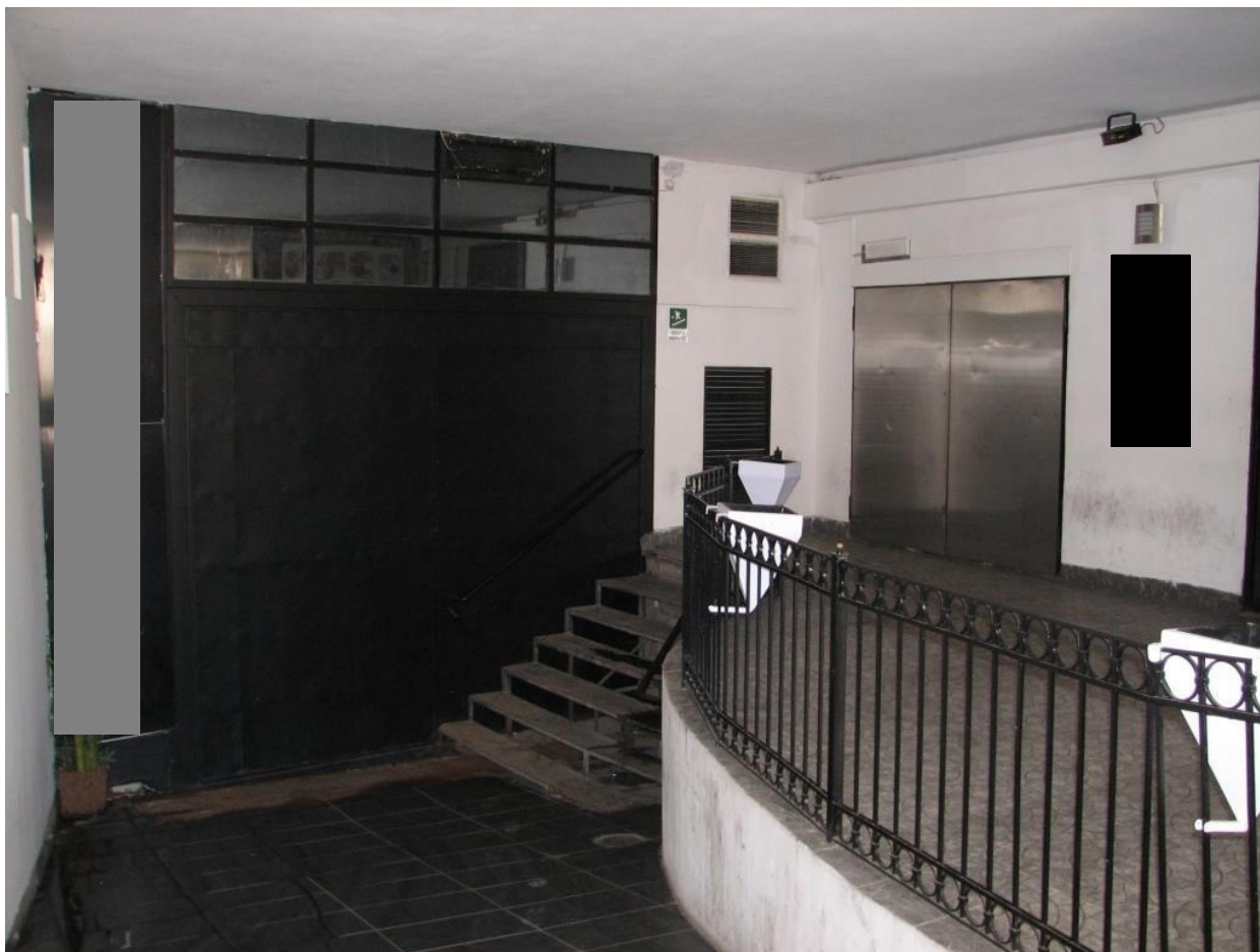
Foto 5 – Uscita di sicurezza del locale discoteca
