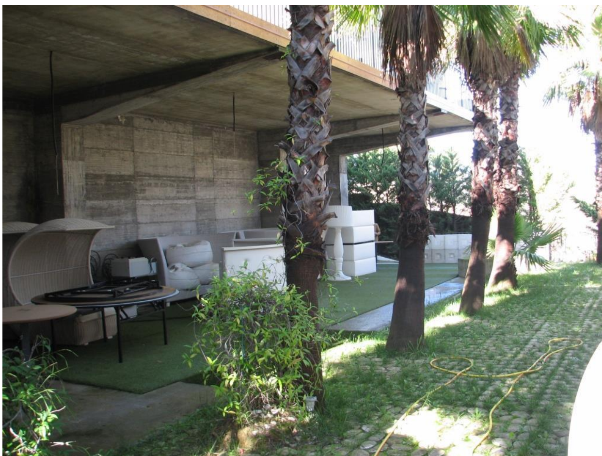
Foto 30 – Esterno, corte (piano primo) ad uso giardino con tettoia
