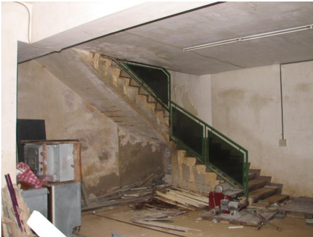
Foto 37 – Interno deposito, scala con uscita murata al piano superiore
