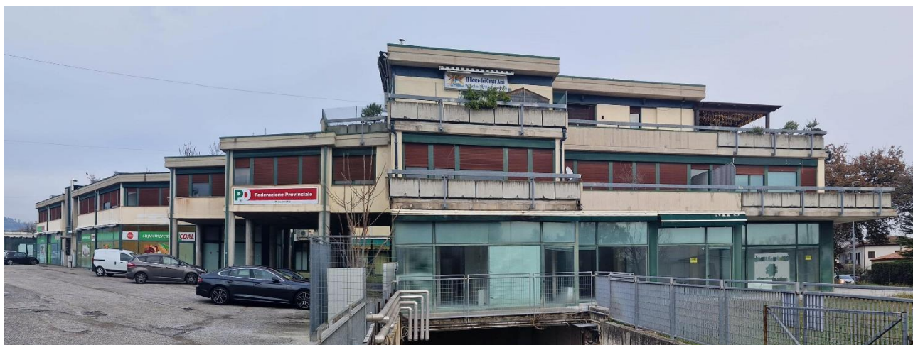
FOTO 1 – Vista generale del fabbricato da Via Volturno
