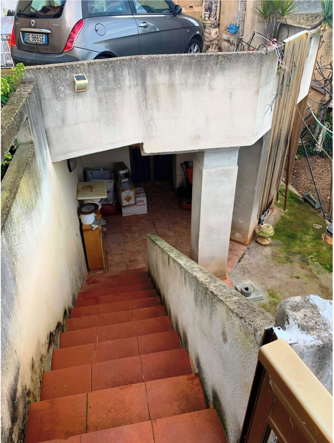
FG 116 Sub 6 - Piano seminterrato (Veranda coperta)
