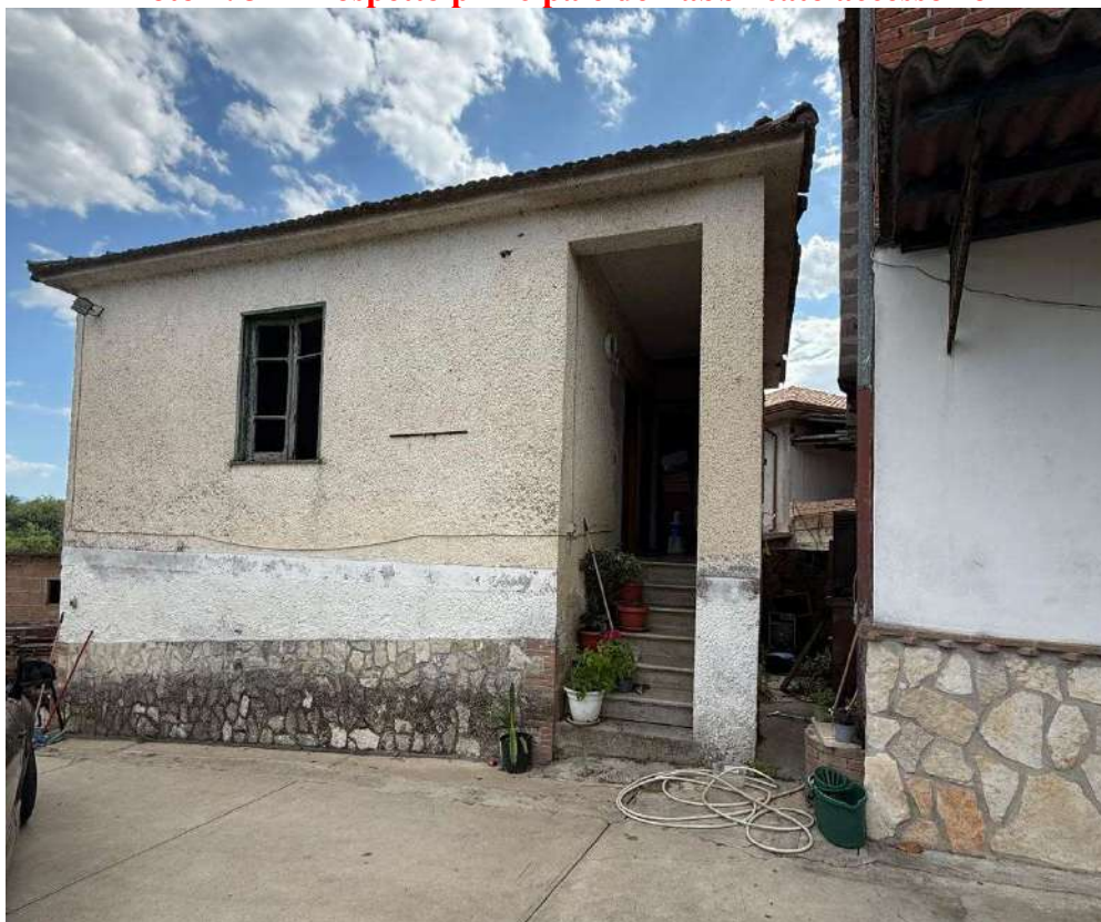
Foto n. 3 – Prospetto principale del fabbricato accessorio
