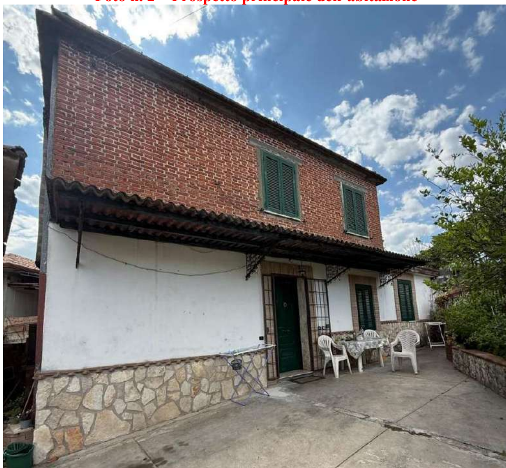
Foto n. 2 – Prospetto principale dell'abitazione
