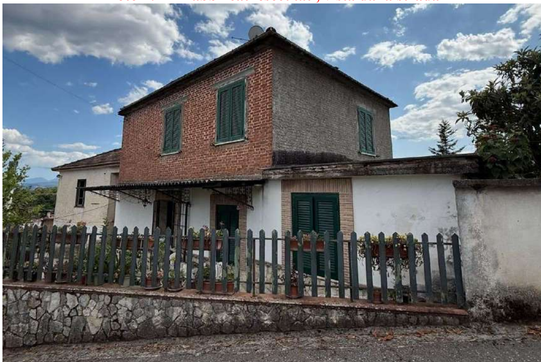
Foto n. 1 – Fabbricati eseguiti, vista dalla strada
