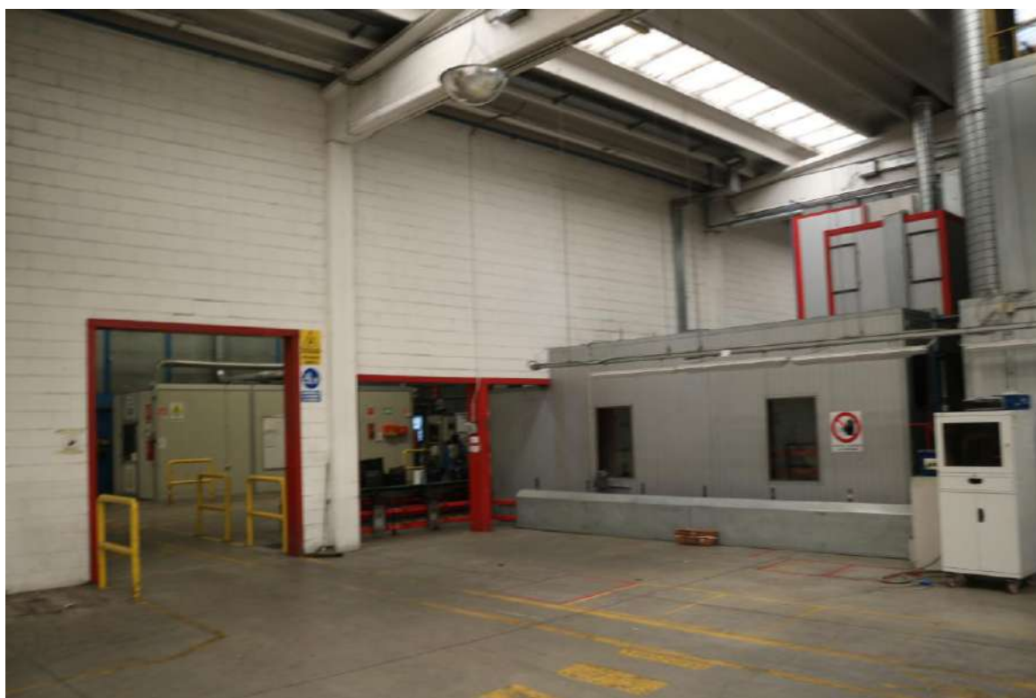
FOTO N°18. - visione interna – CAPANNONE
