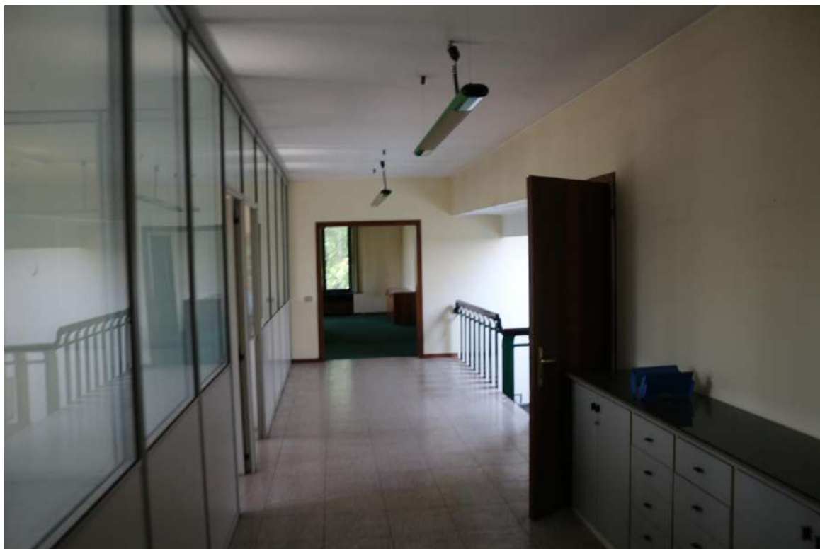
FOTO N°9. - visione interna - UFFICI
