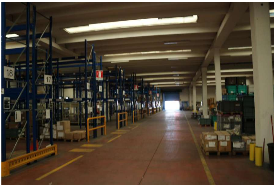
FOTO N°6. - visione interna - CAPANNONE
