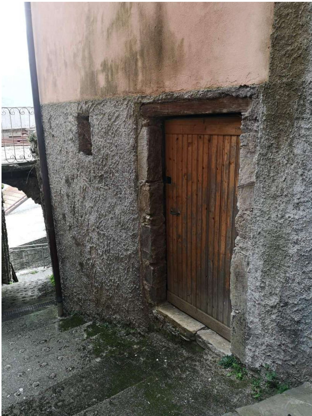
ACCESSO ALLA CANTINA A SUD DELLA STRADA
