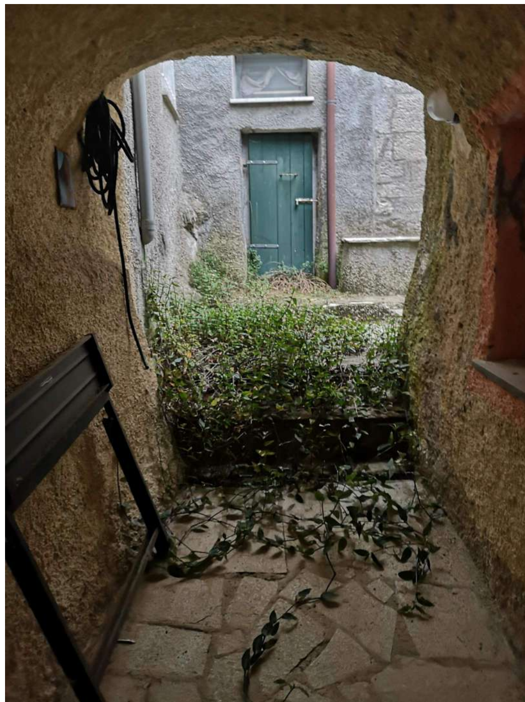
VOLTINO SOTTOSTANTE IL TERRAZZO E CORTE A NORD
