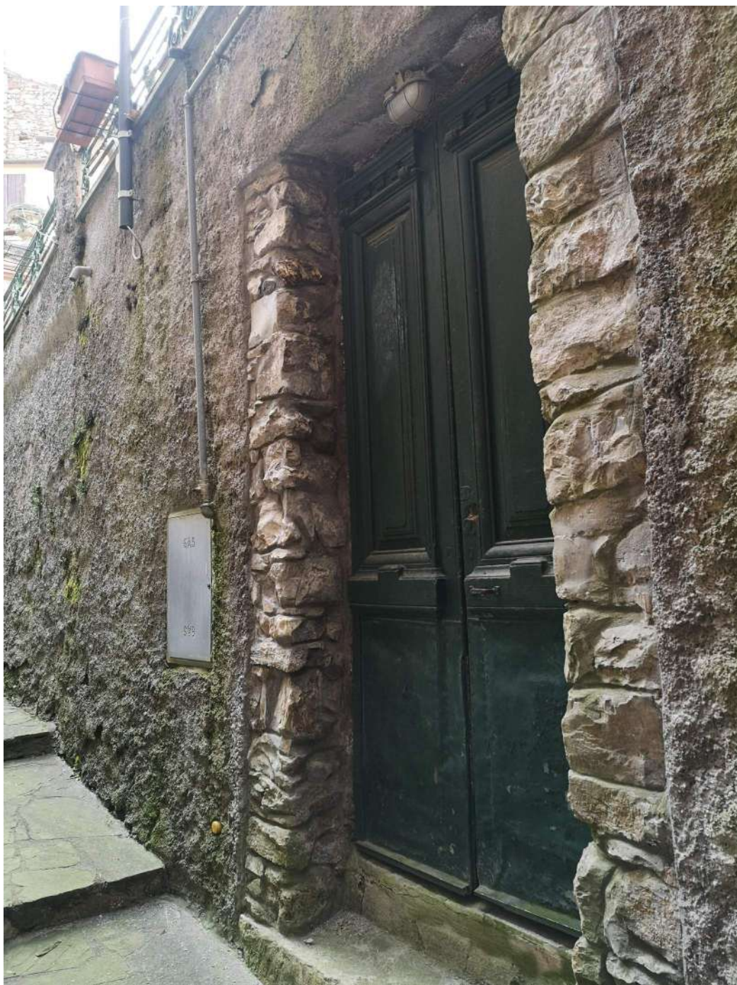
ACCESSO AL VOLTINO (PIANO CANTINE)
