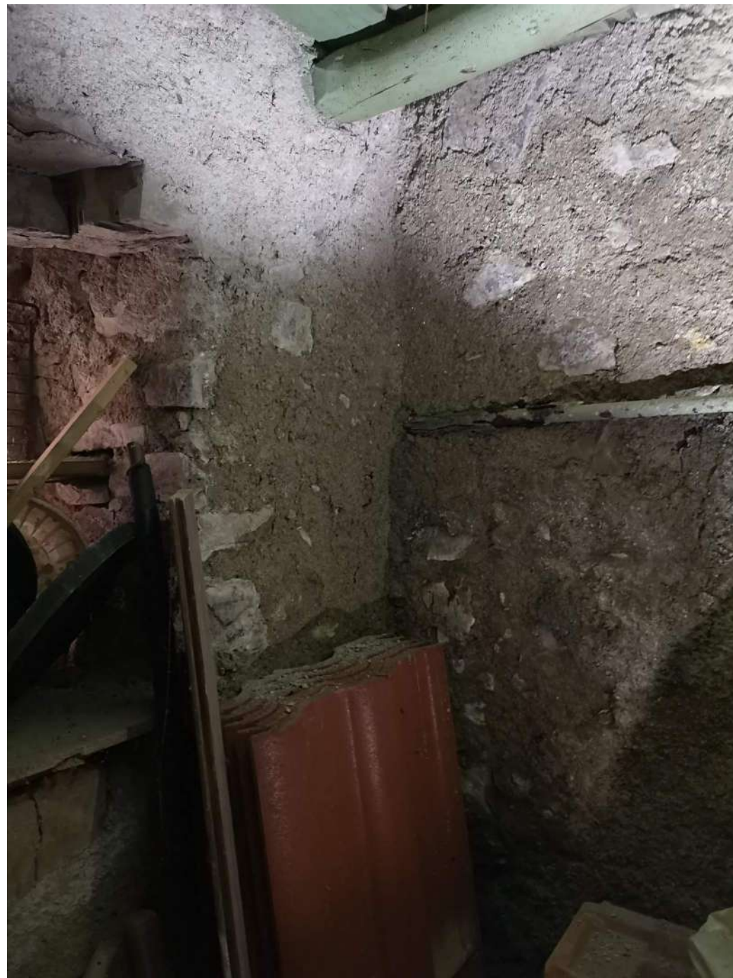
CANTINA A SUD DELLA STRADA
