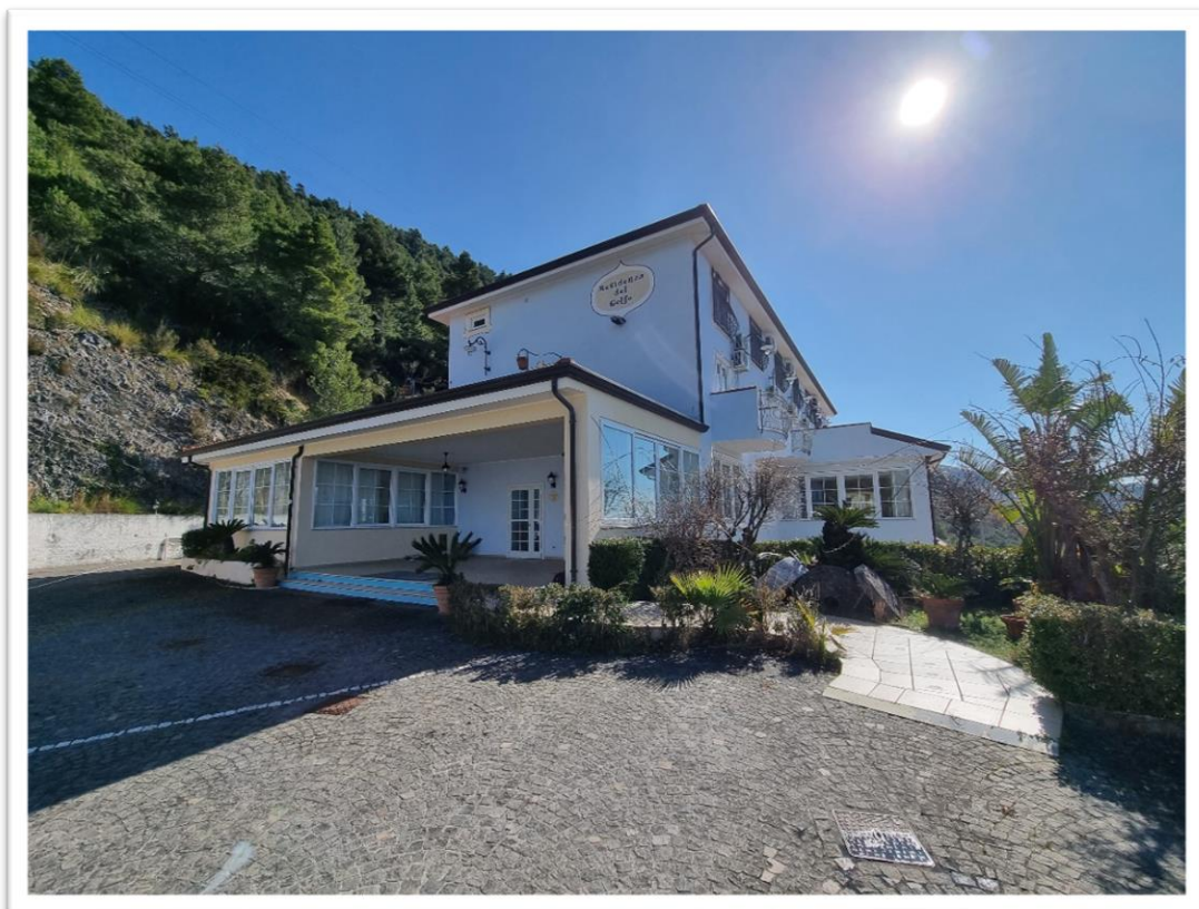
Foto 4 - Vista prospetto Nord/Ovest – ingresso principale
