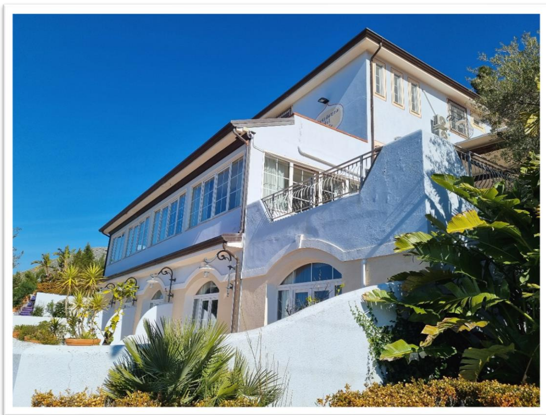
Foto 9 – Vista prospetto Sud/Ovest
