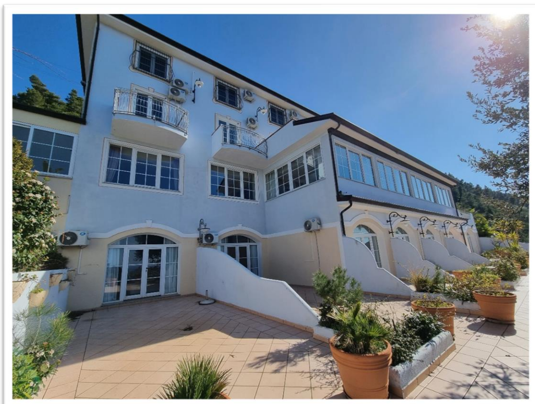
Foto 10 – Vista prospetto Ovest
