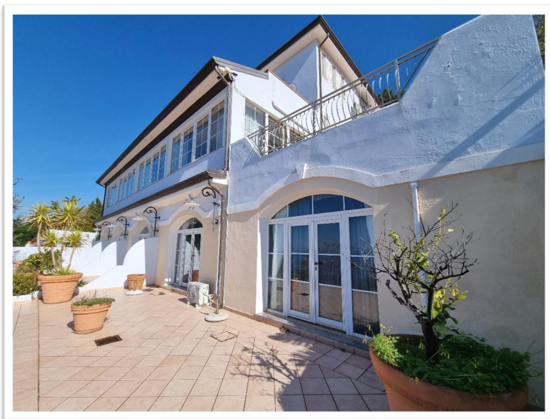
Foto 11 – Particolare prospetto Ovest
