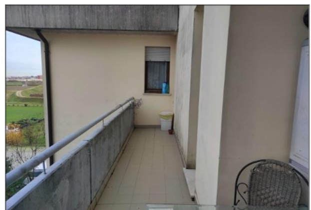
Balcone zona cucina
