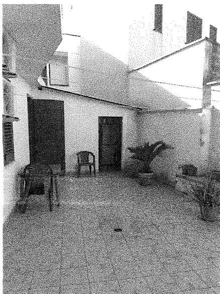
Ripostiglio su scoperto retrostante da demolire
