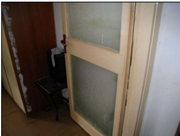
FOTO 26 U.I. MAPPALE 816 SUB. 17 – PIANO SECONDO VISTA PARTICOLARE INGRESSO ALLA CAMERA MATRIMONIALE.
