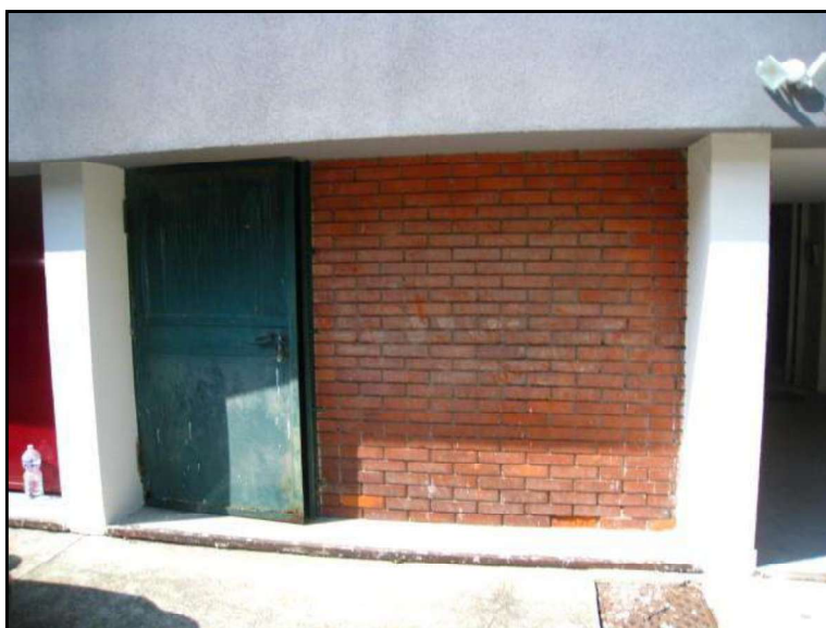
FOTO 36 PIANO TERRA VISTA INGRESSO CANTINA CON ACCESSO DALL'ESTERNO FACENTE PARTE DELL'U.I. MAPPALE 864 SUB. 17 OGGETTO DI PROCEDURA.
