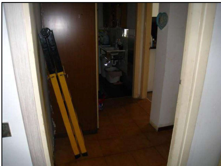
FOTO 20 U.I. MAPPALE 816 SUB. 17 – PIANO SECONDO VISTA DISIMPEGNO NOTTE.
