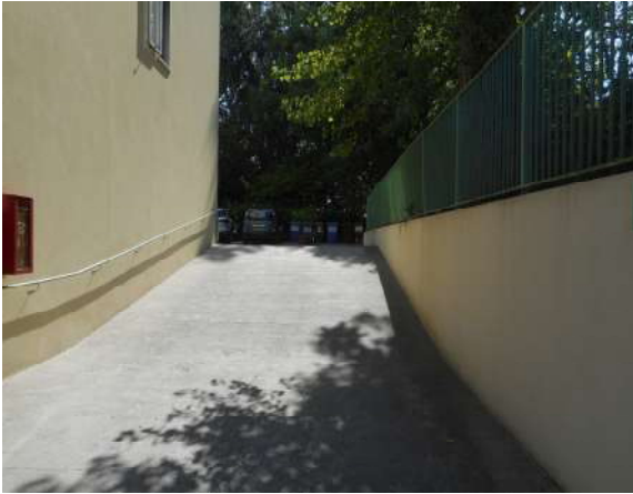
foto 07 rampa verso area comune
