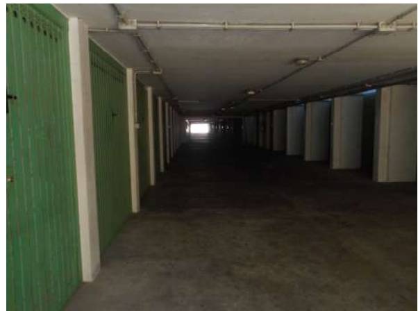
Foto 22 – Corridoio manovra Ps1
