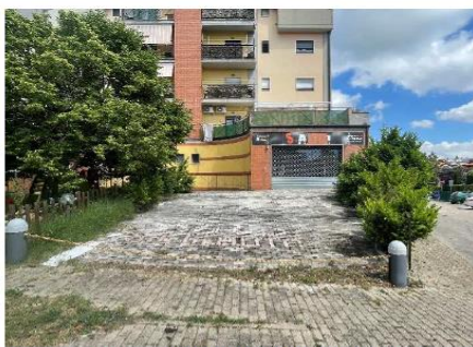
Figura 5: Vista fabbricato da Via Isabella Morra
