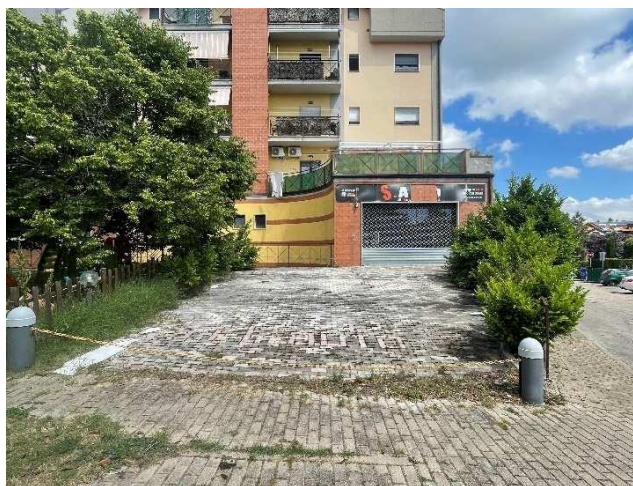
Figura 5: Vista fabbricato da Via Isabella Morra
