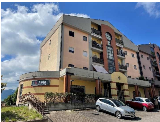
Figura 4: Vista fabbricato da Via Antonio De Curtis
