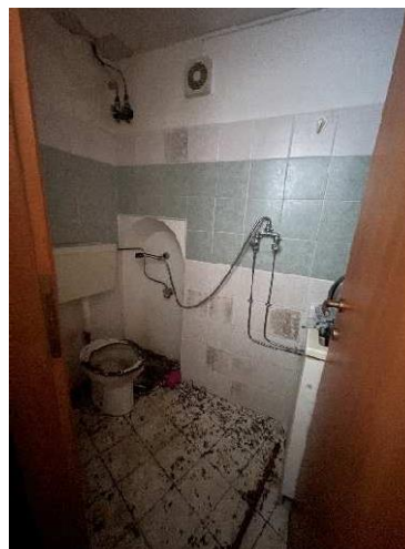
Figura 26: Vista del WC
