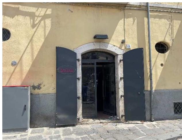
Figura 18: Vista accesso locale staggitto da Via Floriano Del Zio
