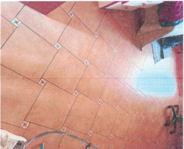
Foto 10 nuova pavimentazione camera da letto (6)
