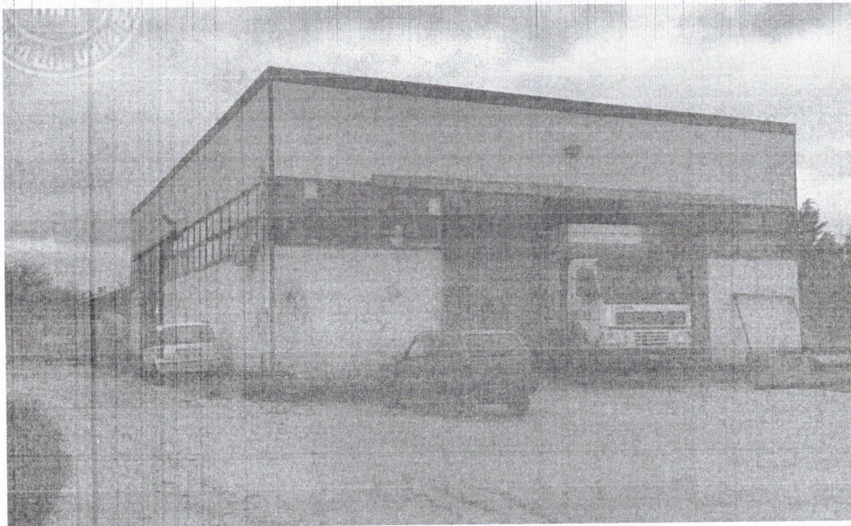
Foto n. 3 - Vista angolo Sud-Ovest
