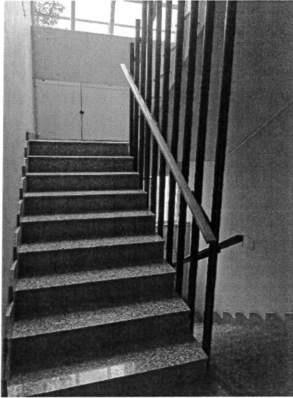
FOTO N.4: vano scala condominiale piano 3
