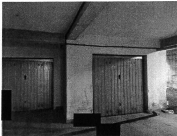
FOTO N.13: porta locale deposito piano s1
