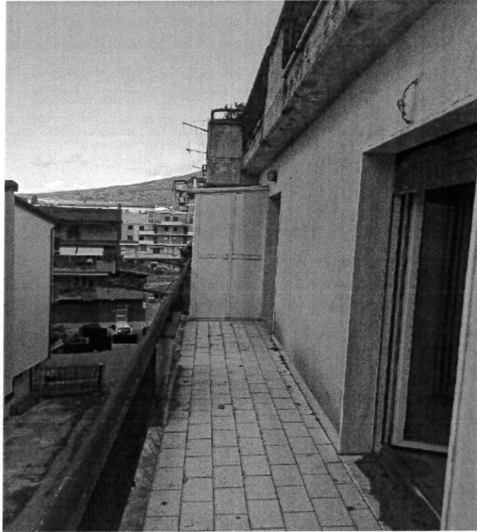
FOTO N.12: balcone prospetto sud-ovest appartamento piano 3
