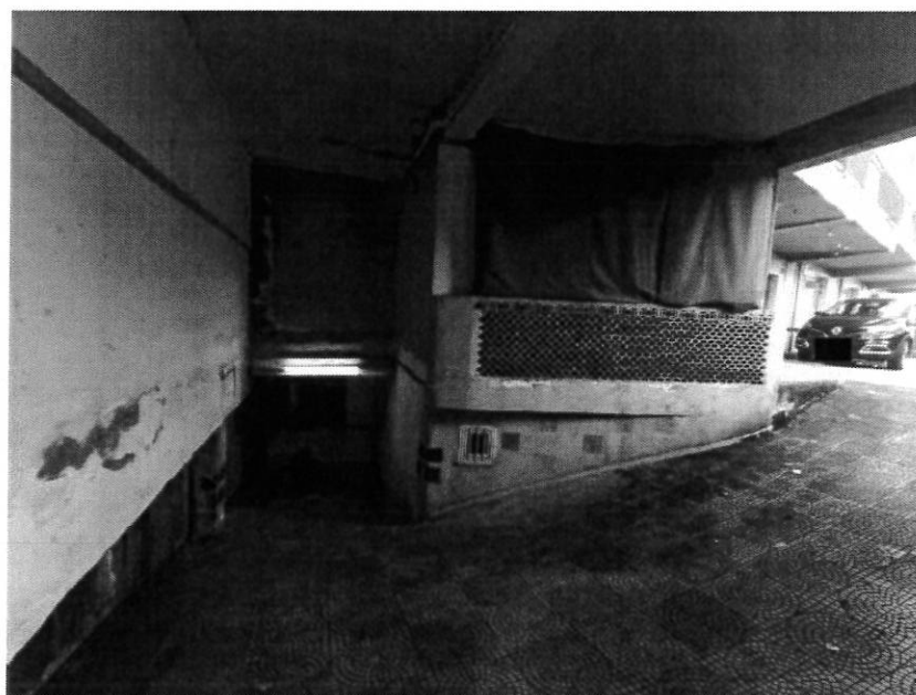
FOTO N.3: rampa interna accesso piano s1
