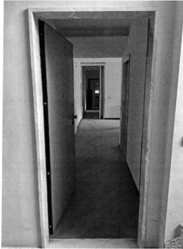
FOTO N.6: porta ingresso appartamento piano 3
