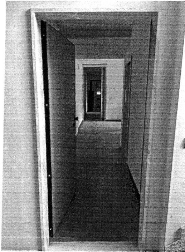
FOTO N.6: porta ingresso appartamento piano 3
