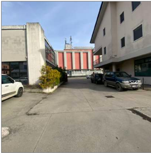
FOTO 6 - L'accesso carroia e pedonale da Via Dal Maso
