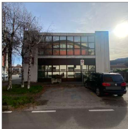
FOTO 5 - Vista da Via Trento - fronte Nord
