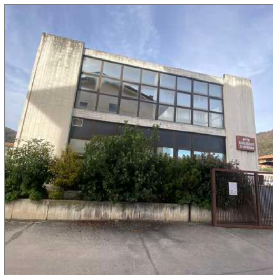
FOTO 3 - Vista dall'accesso carroia/pedonale - fronte Sud
