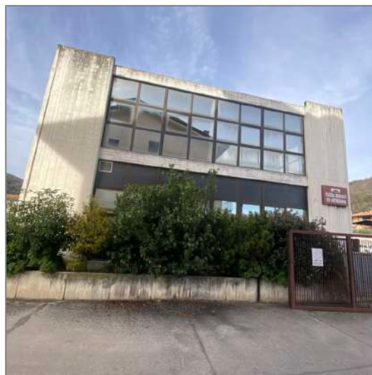
FOTO 3 - Vista dall'accesso carroia/pedonale - fronte Sud
