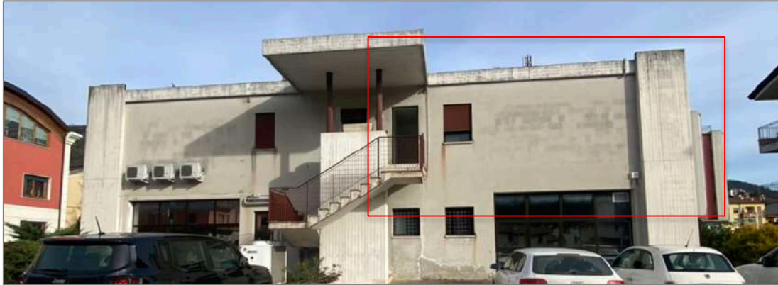
FOTO 9 - Scala di accesso al piano primo
