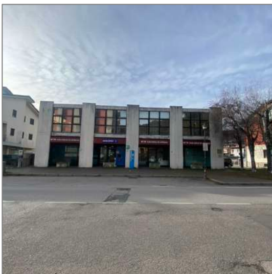
FOTO 2 - Vista da Via Dal Maso - fronte Est
