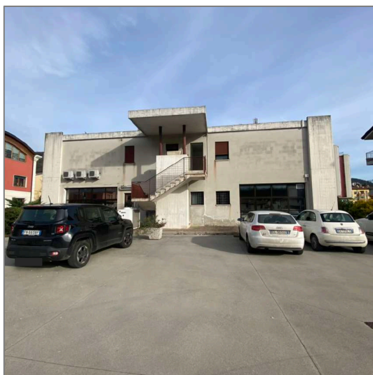
FOTO 4 - Vista dalla corte comune - fronte Ovest
