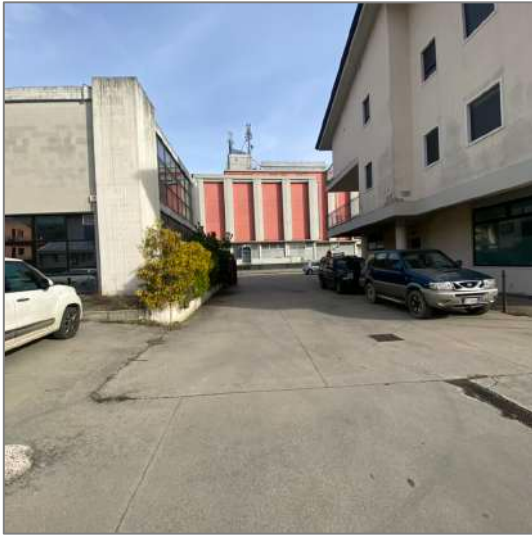
FOTO 6 - L'accesso carraio e pedonale da Via Dal Maso
