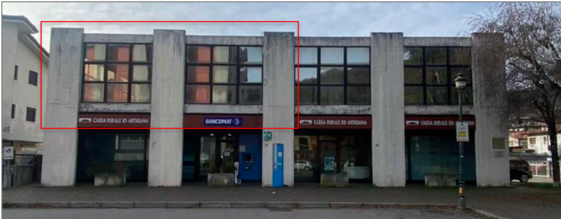
FOTO 8 - L'unità al piano primo subalterno 22
