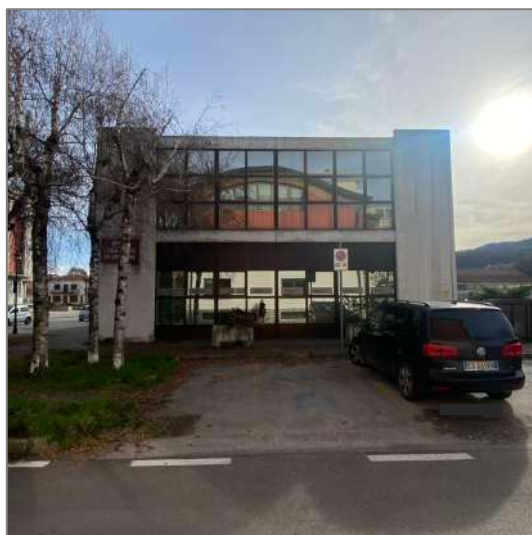
FOTO 5 - Vista da Via Trento - fronte Nord
