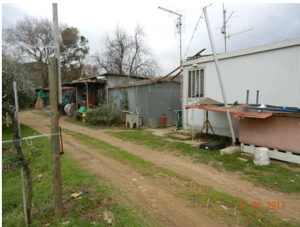
VISTA 14 TERRENO AGRICOLO - ILLECITI EDILIZI
