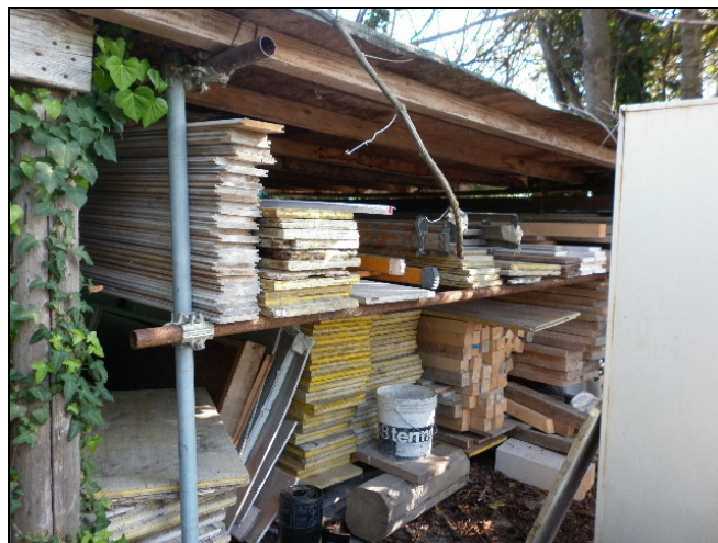
Foto n. 14: Vista tettoia da rimuovere.
