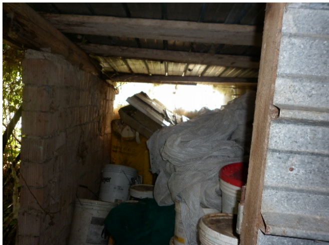
Foto n. 19: Vista tettoia da rimuovere.
