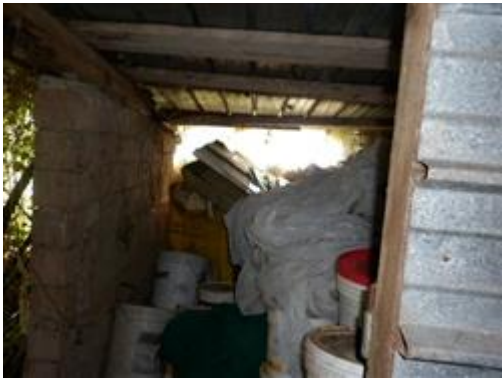
Vista interna manufatti.
