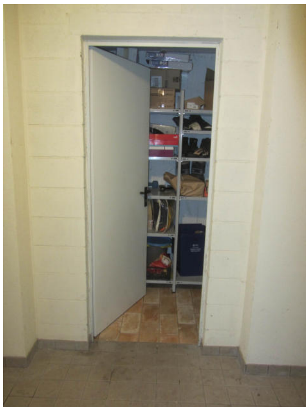
FOTO S.01_ PIANO SEMINTERRATO
