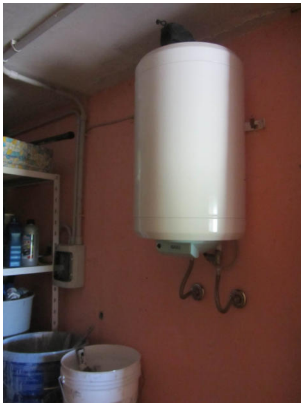
FOTO S.06_ PIANO SEMINTERRATO
