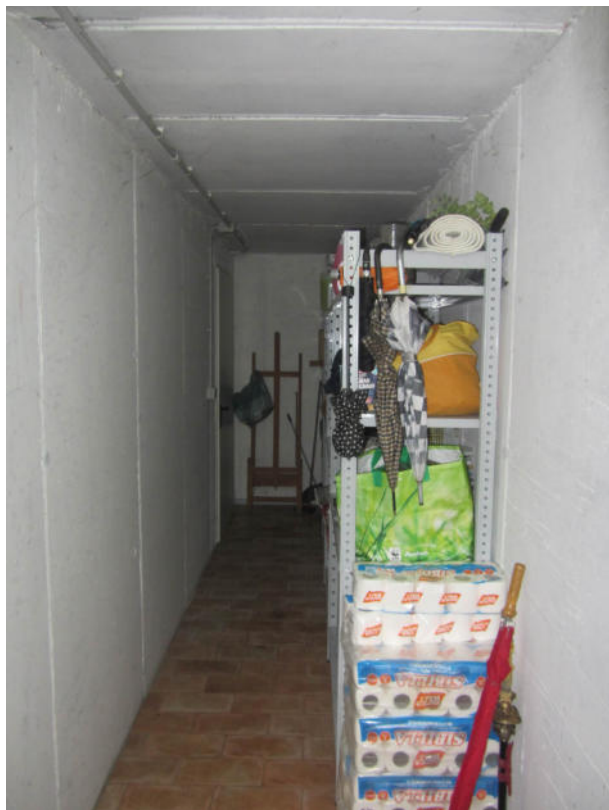
FOTO S.08_ PIANO SEMINTERRATO
