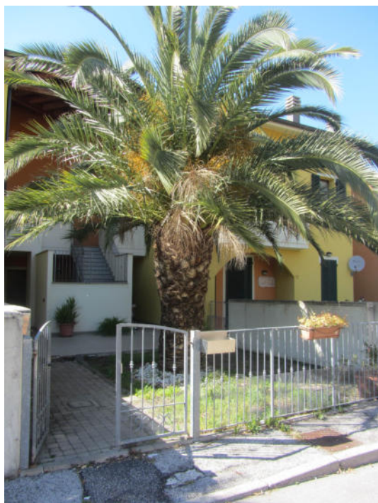
FOTO E.01_ ESTERNO_frente strada
