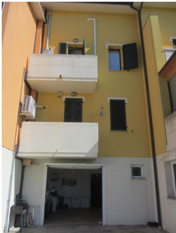
FOTO E.07_ ESTERNO_ prospetto retro
