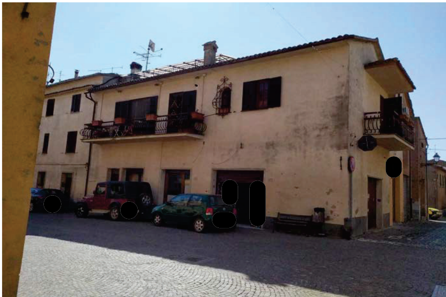
Vista del fabbricato con affaccio su Via Umberto I
