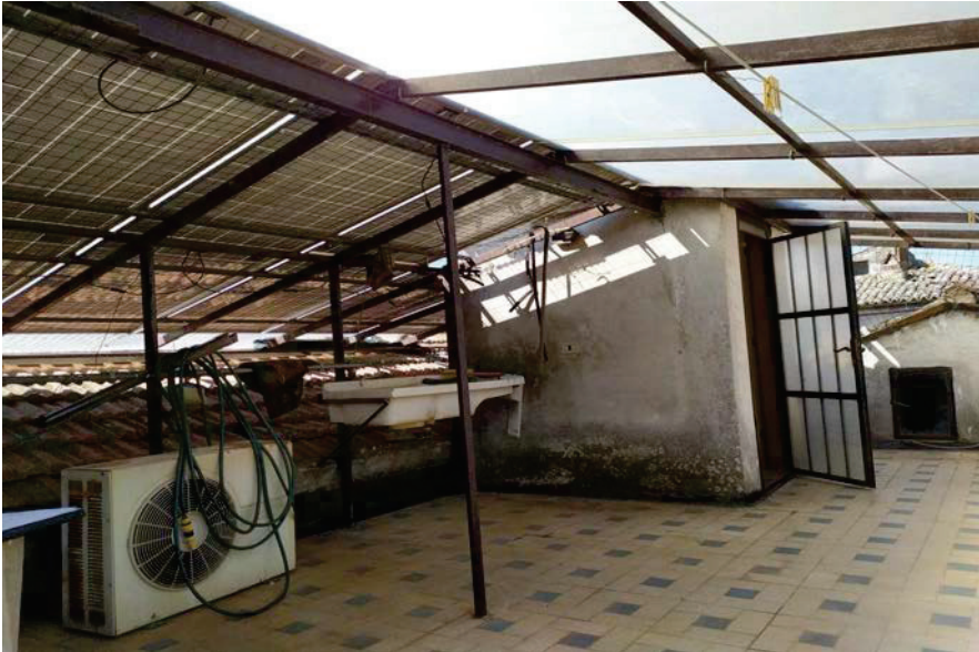
Terrazza con copertura e pannelli fotovoltaici da rimuovere
