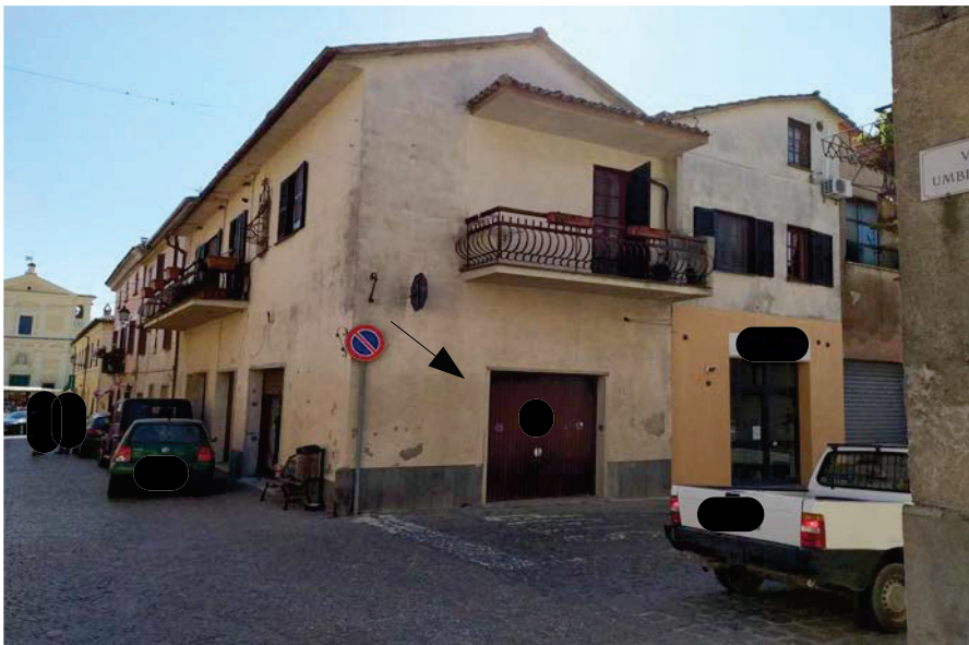
Vista del fabbricato con affaccio su Via Fontana del Mascherone Si nota la porta carrabile da ripristinare
