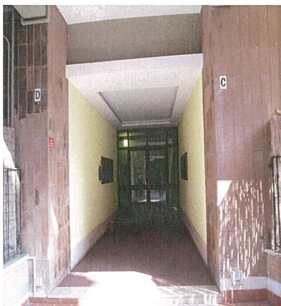
Foto n.4 Ingresso alla Palazzina "B" Scala C in cui insiste il bene esecutato al piano 2° Int. 9.
