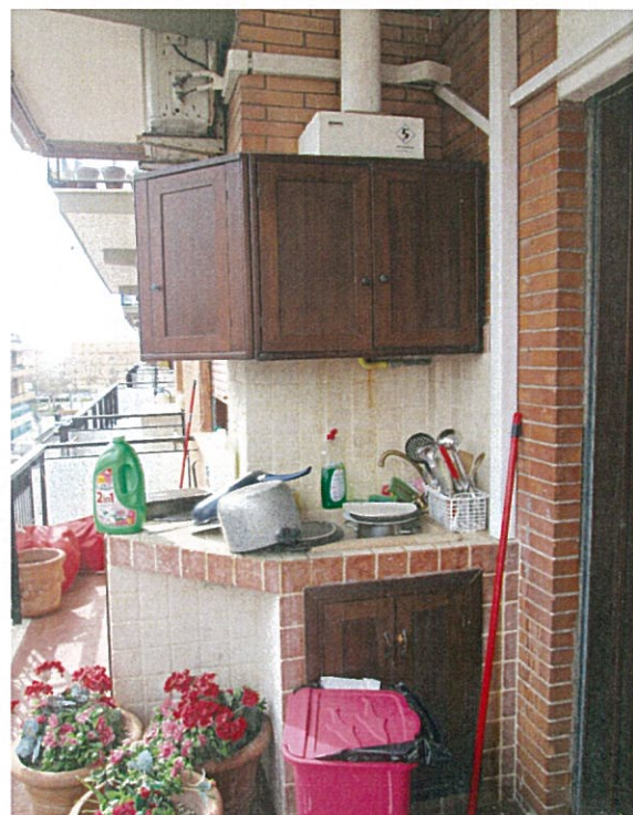
Foto n. 17 Balcone attrezzato con lavello e lavatrice.
