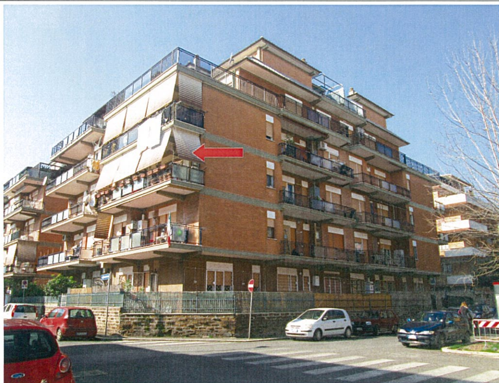
Foto n.2 Fabbricato in cui ricade al piano secondo l'appartamento esecutato.
