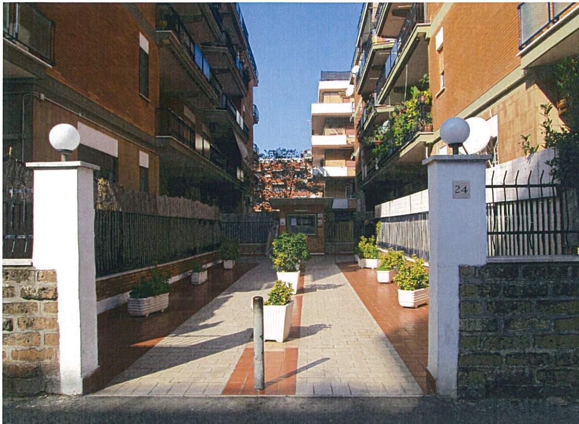
Foto n.3 Ingresso agli edifici "A" e "B". Via La Spezia n.24
