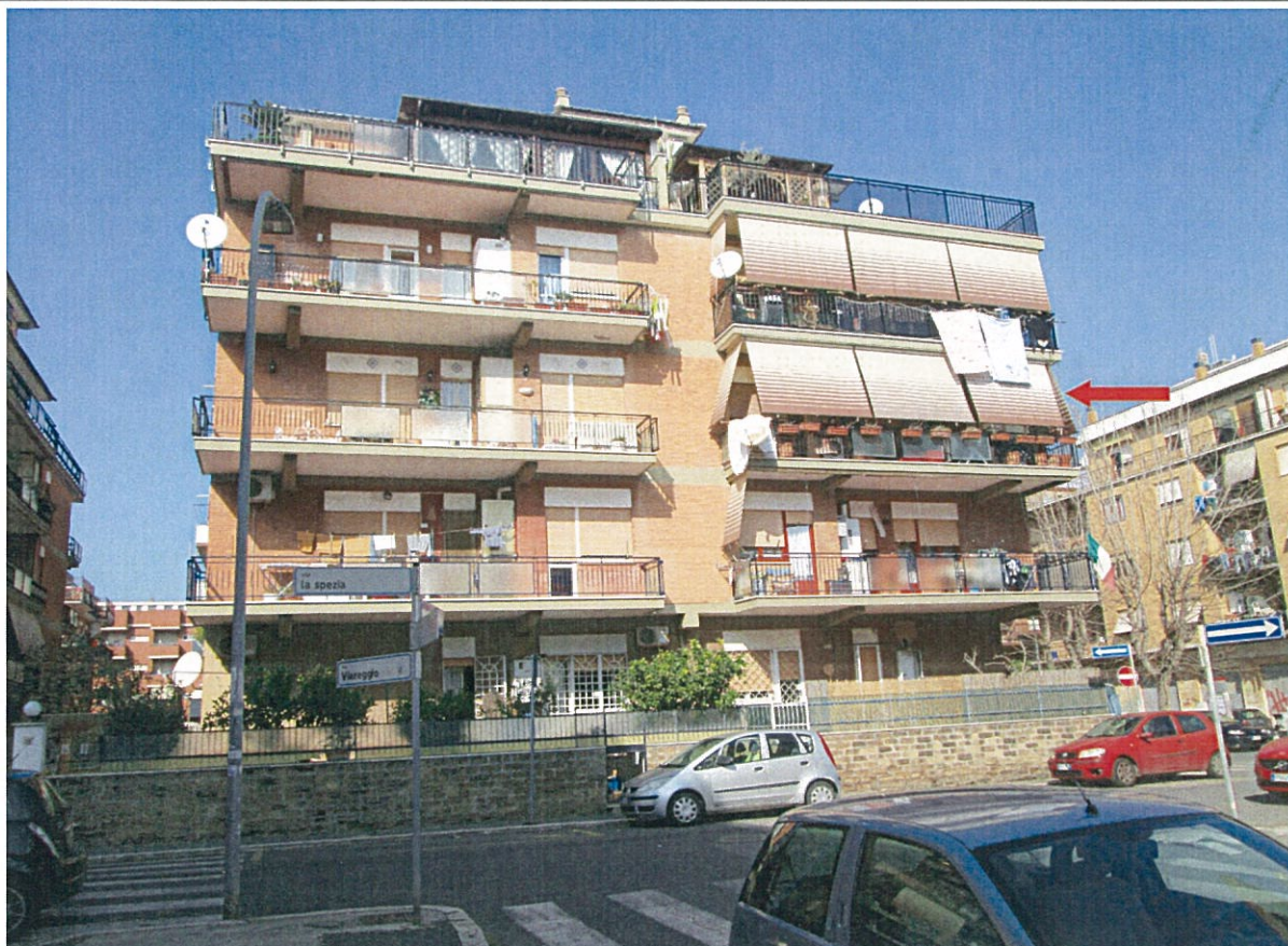
Foto n.1 Fabbricato in cui ricade al piano secondo l'appartamento esecutato.
