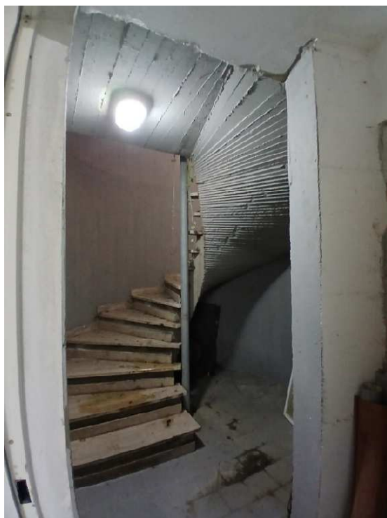
- Piano seminterrato - scala a chiocciola che sale al piano del resede (piano terra)
