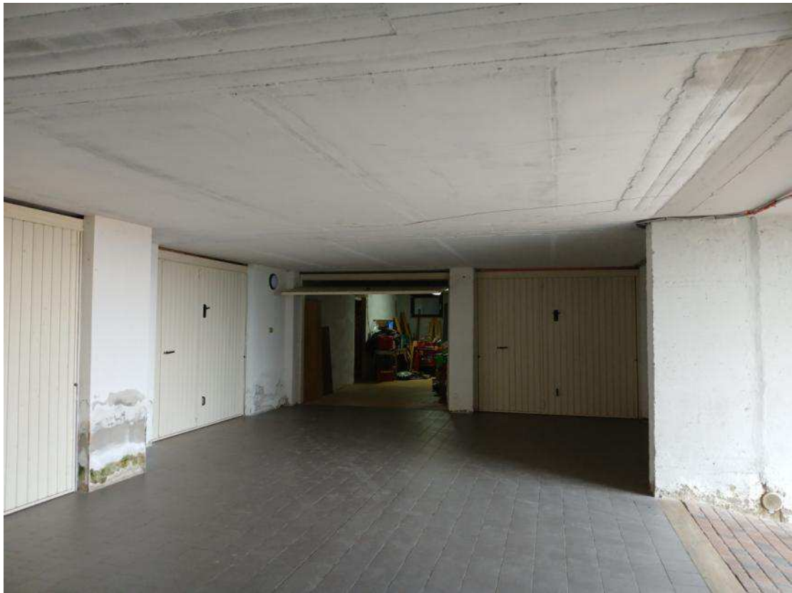
Ingresso al garage di proprietà (sub. 20) dalla corsia condominiale
